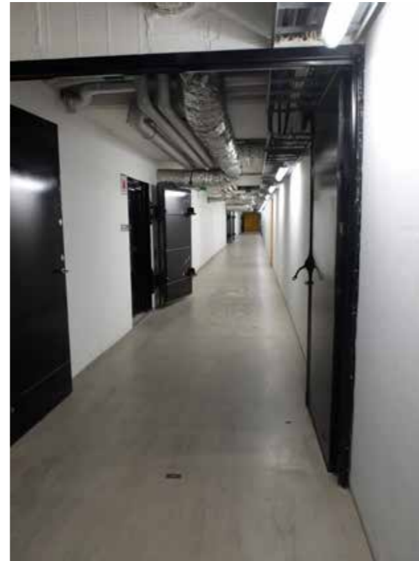
Lång korridor i källarplan med flertalet skyddsrum finns kvar sedan byggtiden.
