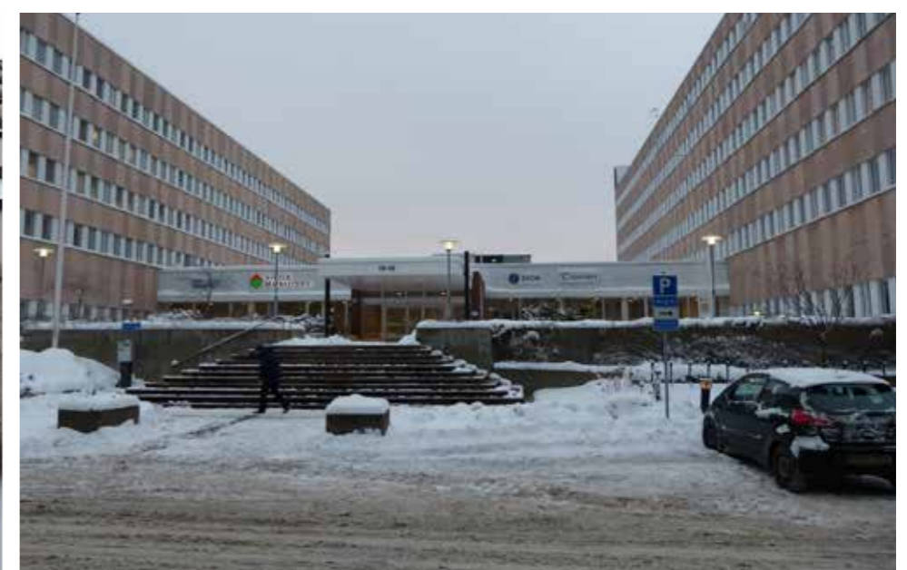
Entrén mot Smidesvägen. Innan fasaderna målades om 2015. Foto: Tyréns AB 2013.
