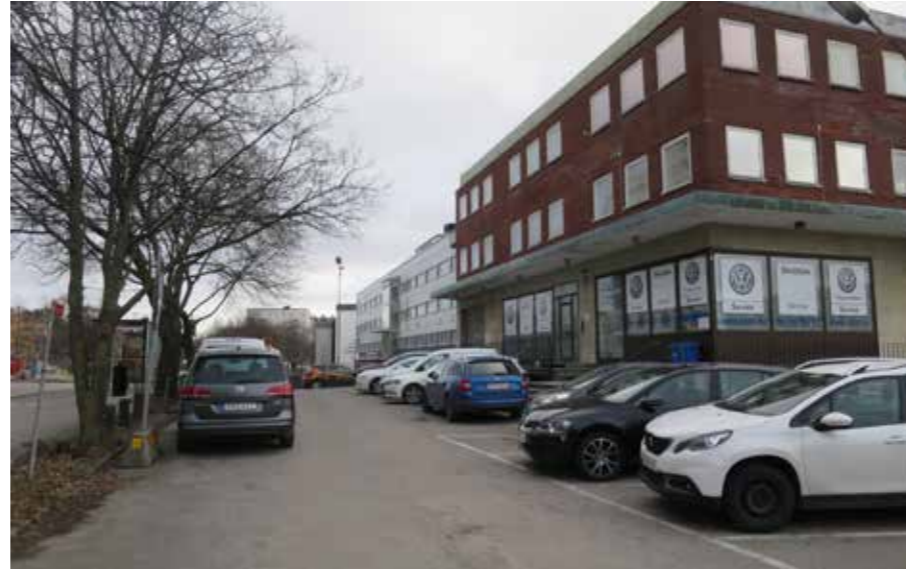
Sliparen 1, kontor- och försäljningsdel. Byggnadens entré är riktad mot Ekensbergsvägen.
