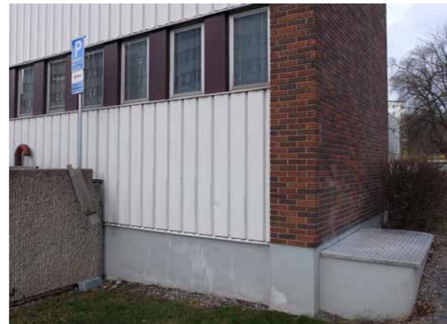
Ljust gråmålad betongsocker står mot vitlackad plåtfasad och mörkt röd tegelgavel.
