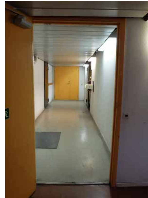
Källarutrymmen med dörrar i gullackad plåt.
