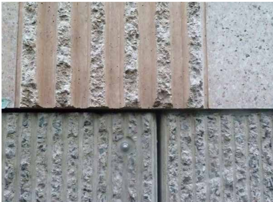
Socklarna i betong är räfflade med släta nedsänkta och röhuggna upphöjda partier, dock i lägre relief än fasaderna. Foto: Maria Wannberg
