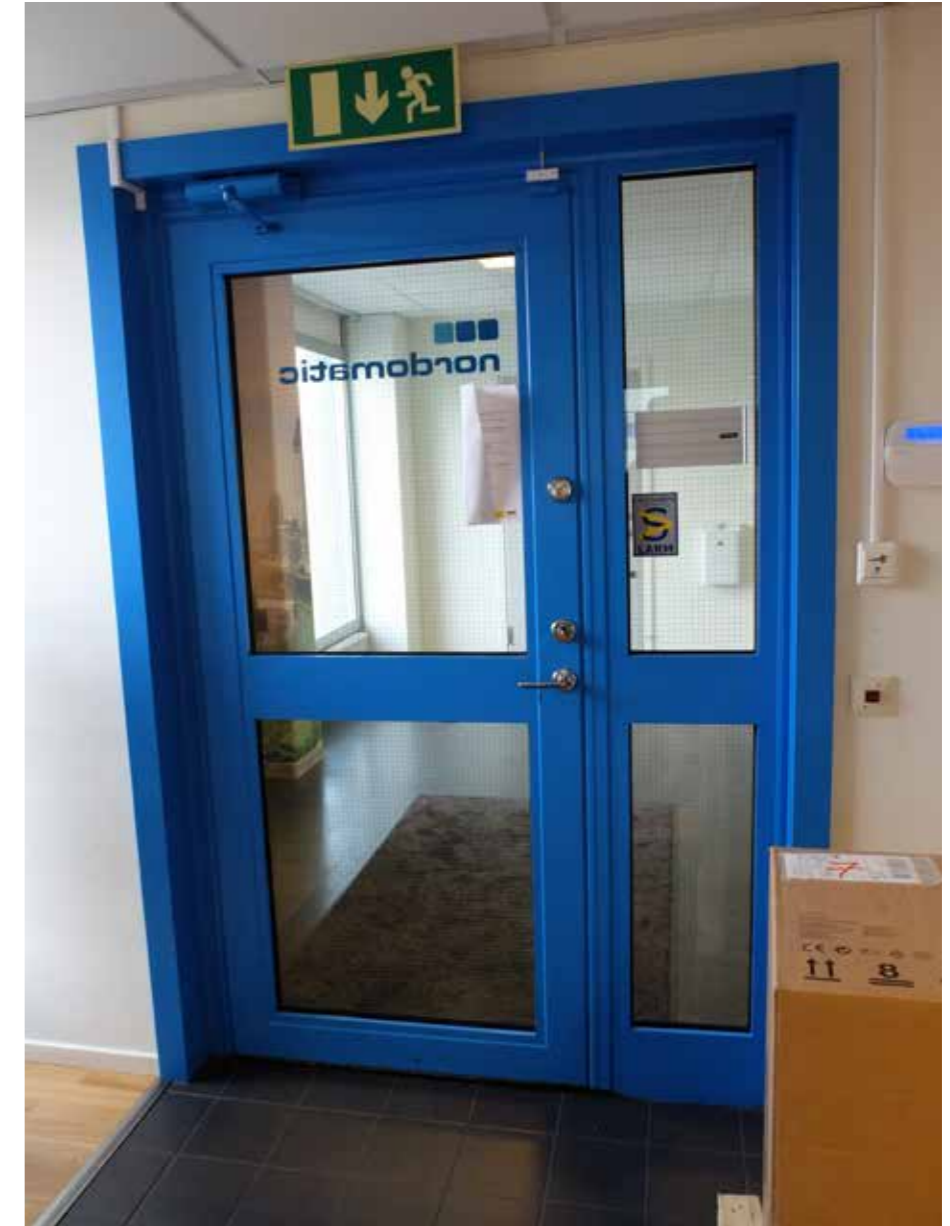
Ej ursprunglig entrédörr till plan 2, det lackade partiet med glasad dörr och sidoljus markerar tydligt entrén från huvudtrapphuset.
