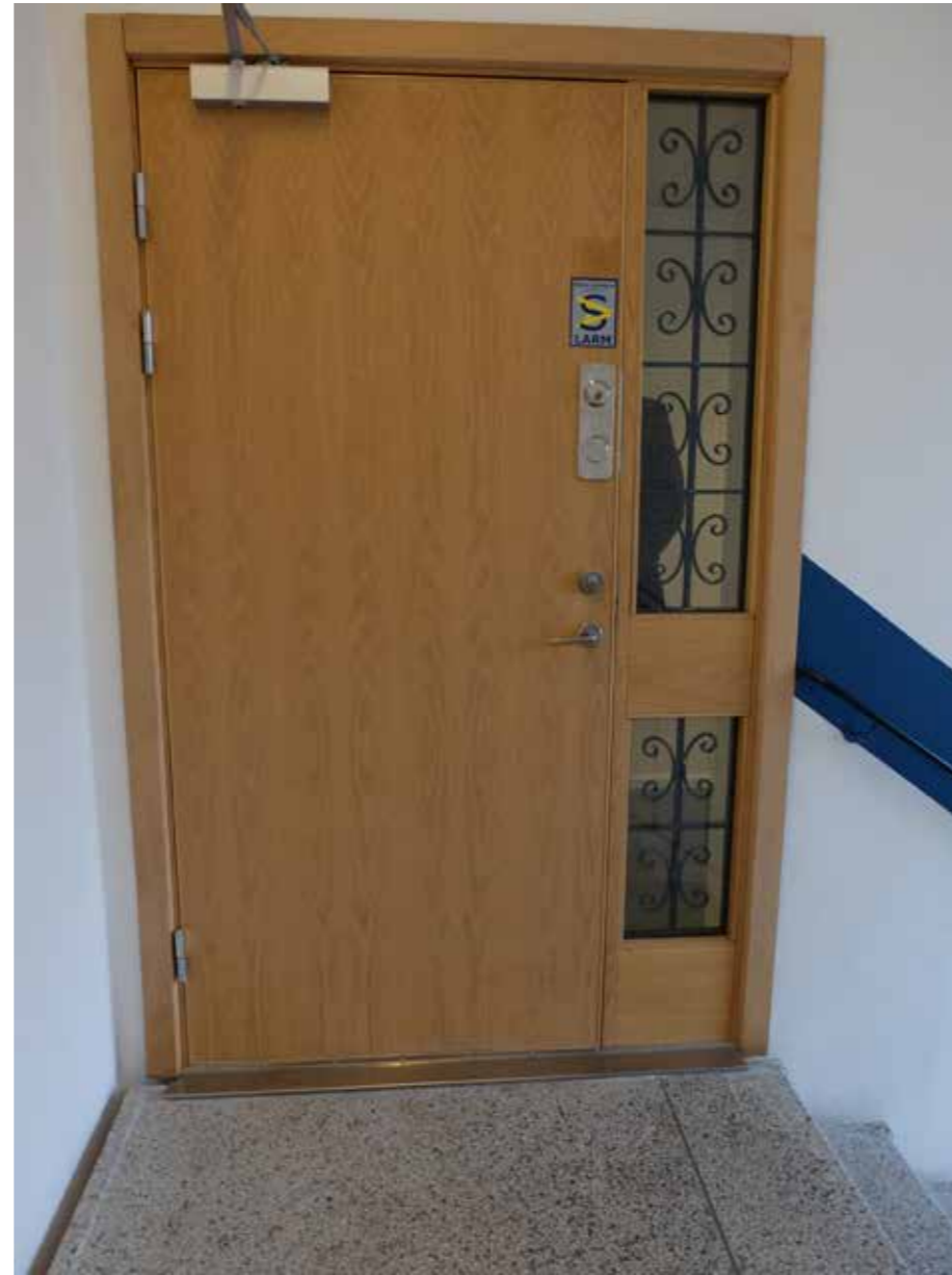
Dörr i lackat trä med sidofönster leder från utrymningstrappa till kontorsplanen, kan vara ursprunglig. Det finns likadana på övriga våningsplan.
