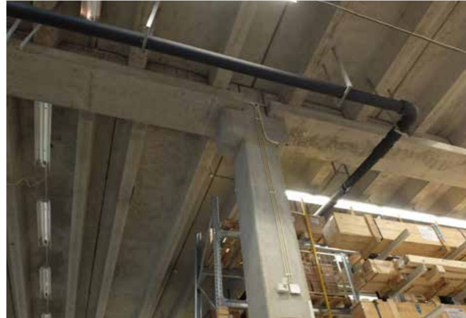
Närbild på den omålade betongstommen, här med synliga TT-kassetter.
