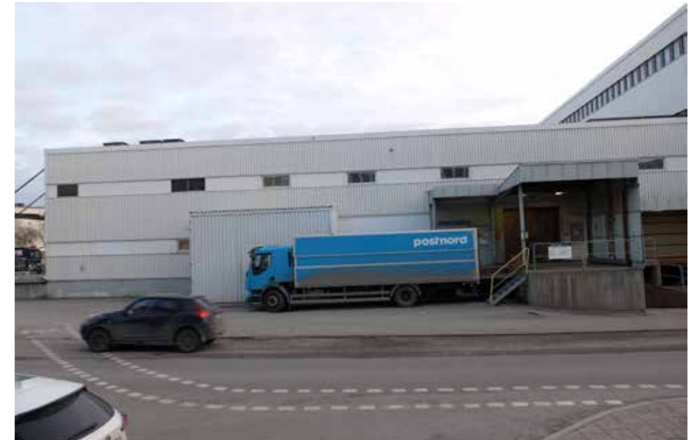
Mot Smidesvägen ligger också in- och utlastning till lagerbyggnaden. Lastkajerna och nedfart till källarplanens garageytor har byggts om vid två tillfällen.
