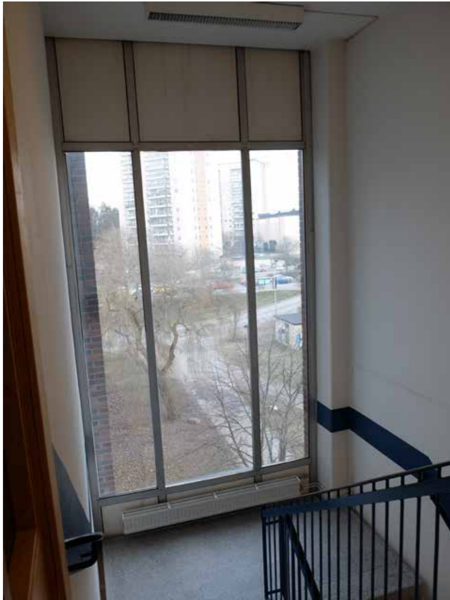
Stora fönsterpartier i gavelparti i sydöst. Fönstret ger här ljus till utrymningstrappan.
