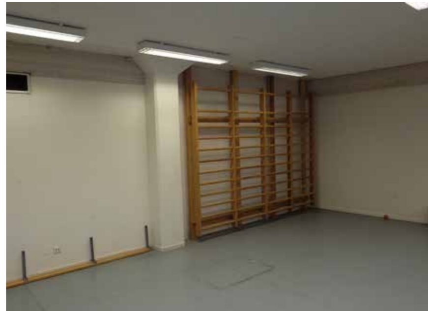
I källarplanet ligger motionsrum med intilliggande omklädningsrum, ett rum som sannolikt inte genomgått några större förändringar sedan byggtiden.
