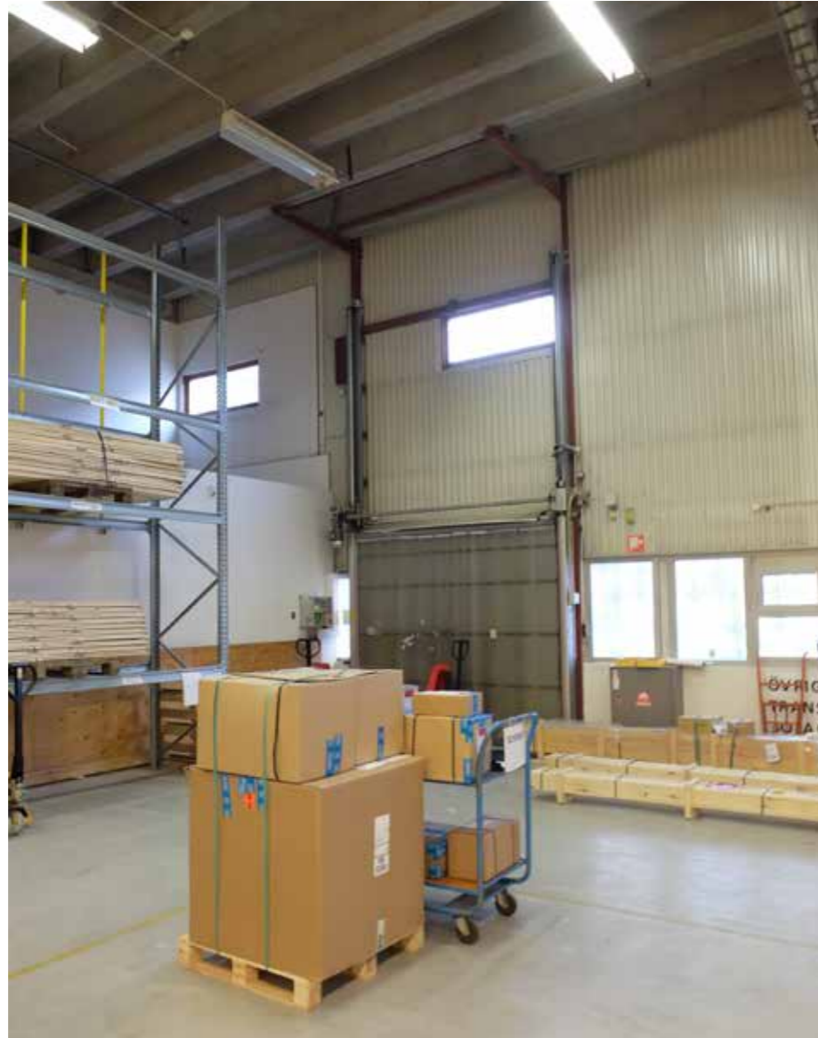
Innervägg i lagerbyggnaden med portar för in - och utlastning mot Smidesvägen. Även innerväggarna är klädda med korrugerad plåt.
