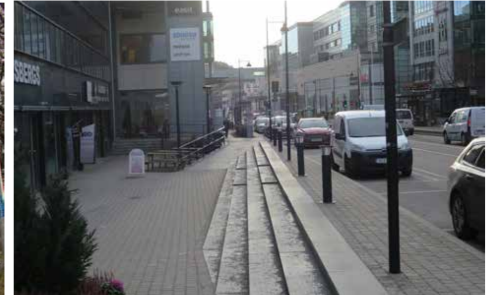
Svetsarvägen som löper genom området har breda trottoarer och är en tydlig struktur. Mot Ekensbergsvägen mynnar vägen mot Sundbyberg.
