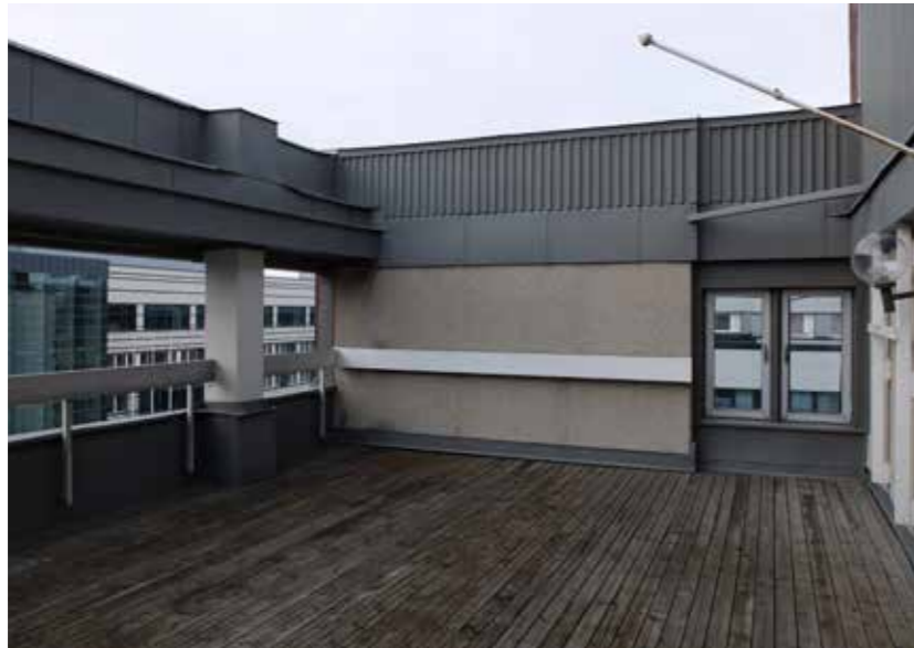
Terrass på plan 6 i hus 1 i anlutning till kontorsytor och de delar som ursprungligen tillhörde styrelsen. Utsikten är mot spårområdet.
