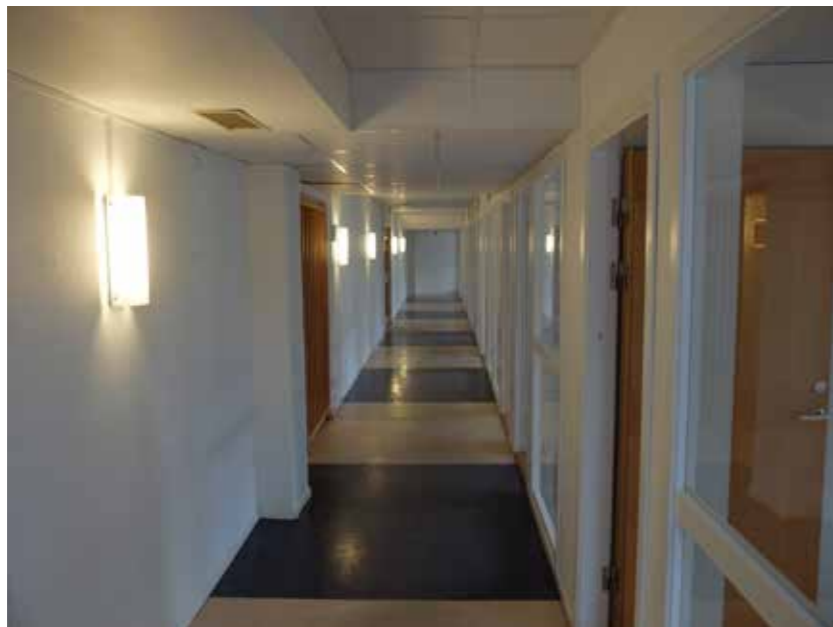
Plan 6, i västra lamellhuset (hus 1), i den delen där styrelserummen låg. Kapprummen med träspaljé till vänster finns sannolikt kvar sedan byggtiden, i övrigt har de flesta rummen byggts om och en korridor har skapats. I övrigt karakteriseras detta våningsplan av små cellkontor längs smala långa korridorer. Våningsplanet har delats av varför korridorerna inte kan upplevas i sin helhet. Dörrar till trapphus och kontorsrum samt träspaljén visar sannolikt ett ursprungligt utförande. Idag är de flesta snickerier och väggar vitmålade.
