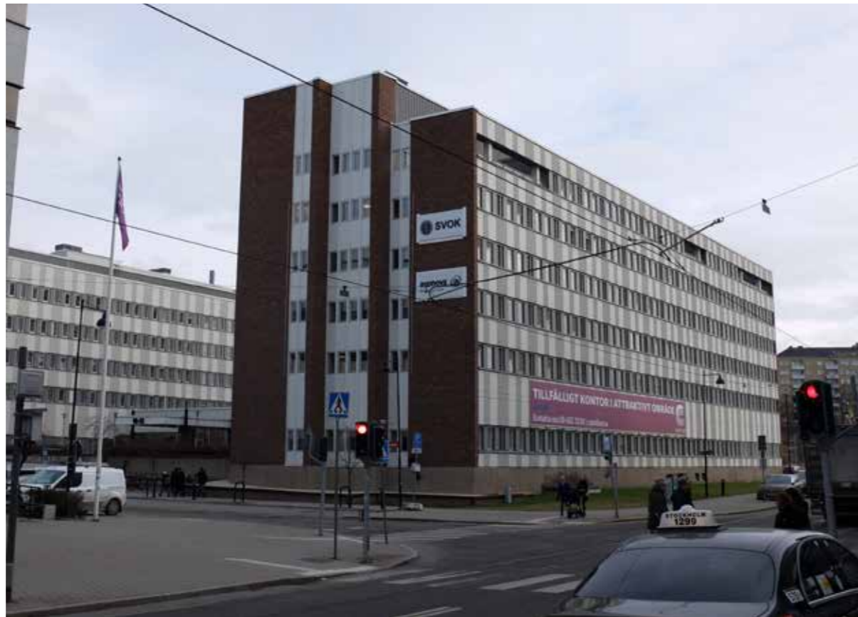
Fasadernas betongpartier på långsidorna är sedan 2014 målade ljus grå och fönster och plåtpartier grå medan gavlarna har kvar vita plåtpartier och mörkrött tegel. Betongsockeln är omålade.
