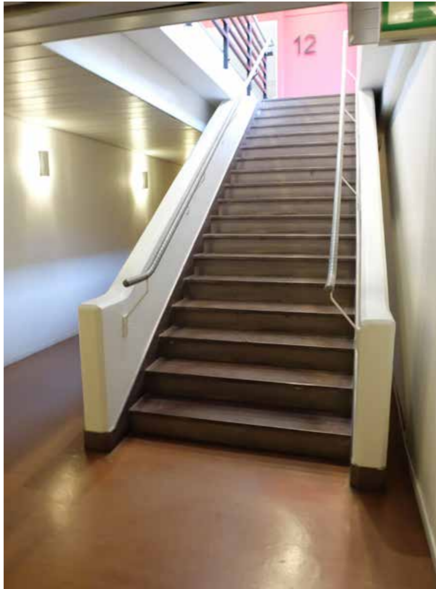
Trappa mellan källare och entréplan. Trappsteg beklädda med samma typ av rödbruna kalkstensskivor som i entréplanet och trapphuset.
