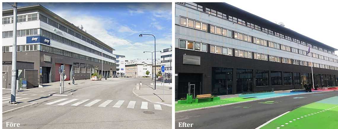
Figur 8. På Englundavägen före och efter ombyggnaden med separerad gång- och cykelbanan på den södra sidan av gatan och uppgraderad gångbana på den norra sidan av. Bilden visar den del av gatan som angränsar till Sliparen 1.
