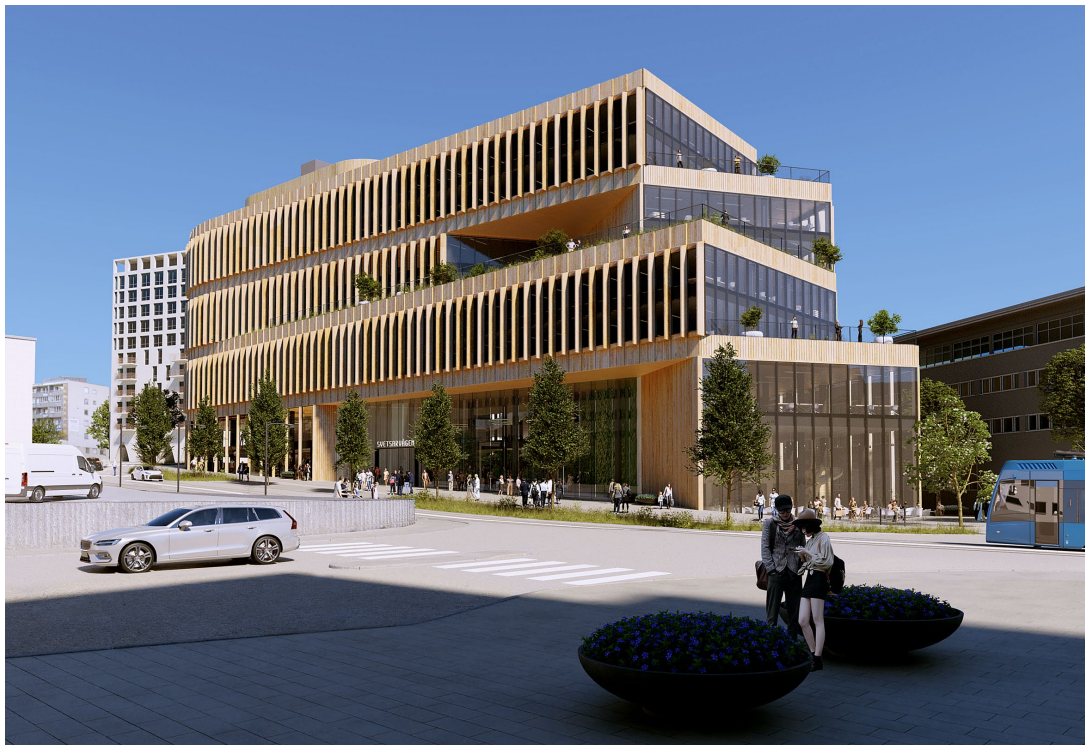
Figur 3. Den nya byggnaden sett från Svetsarvägen mot norr.
