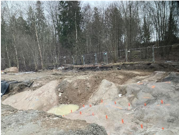
Figur 6. Området efter utförd delsanering. Synligt i schaktvägg är kvarlämnad asfaltsfyll med halter över FA (se Tabell 1). (2022-12-21)
