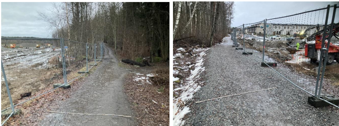
Figur 7. Gångvall som bedöms vara delvis fylld med asfalt. Gångvall lämnades kvar efter decemberens delsanering. Utlagd tumstock är 2 m lång. (Vänster) Utsikt österut. (Höger) Utsikt västerut mot Kv Grankällan. (2022-12-21)
