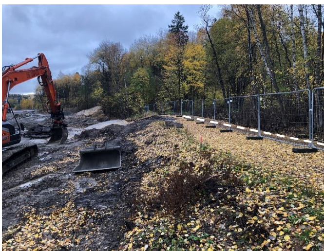
Figur 3. Område där asfalt påträffades, utsikt österut. Vänster i bild syns Krossens pågående schaktentrepnad (ledningsdragning under Gunnarbovägen) och till höger syns den upphöjda vällen för gångstigen som löper parallellt med skogsområdet. Vitstreckad markering är ungefärligt läge för gångstigen. (2022-10-18)
