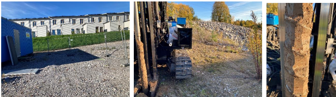
Figur 18. Provtagning i norra planområdet. (Vänster) Placering 22VM34 med utsikt nybyggnation i Kv Grankällan. (Mitten) Placering 22VM36 uppe på höjd. (Höger) Torrskorpelera med rostinslag mellan 2-3 m djup för 22VM36. (2022-10-12)
