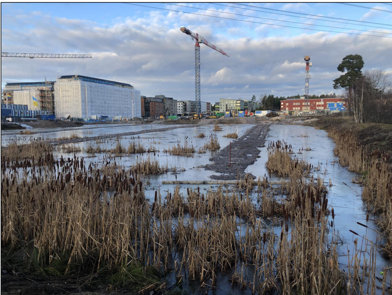
Figur 1 Översvämningsytan, efter schaktning för sanering. Bild från platsbesök 2023-01-18.
