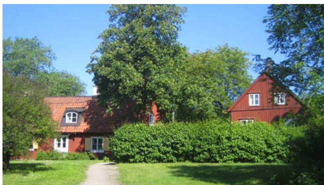
De två byggnaderna inom byggnadsminnet stenbrottet.
