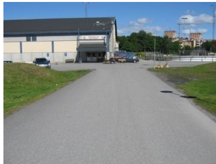
Befintlig ishall strax norr om planområdet. Vy från söder från befintlig infart.
