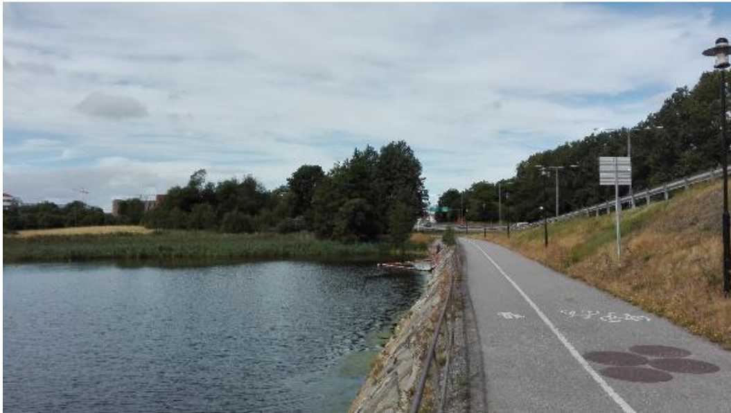
Figur 22. Gång- och cykelbana och stensatt strandkant vid Bergshamraleden (WRS. 2016a).
