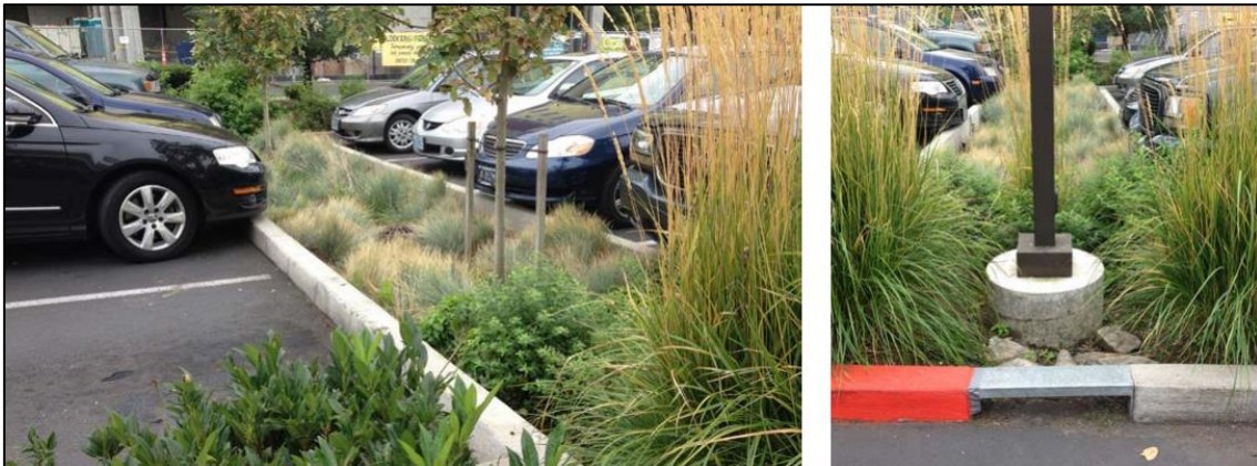
Figur 6-3. Exempelfoto på regnbäddar i gatumiljö där dagvattnet leds in i regnbädden via öppningar i kantstenen (Stockholm Vatten och Avfall, 2022b).
