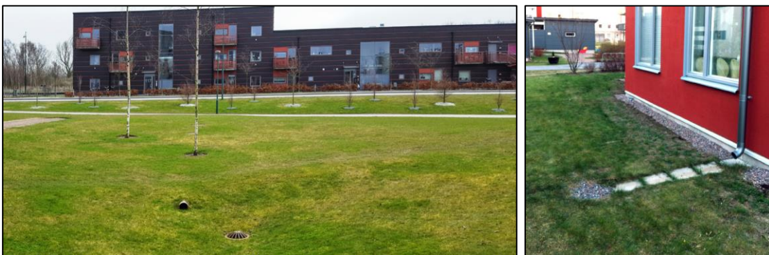
Figur 6-1. T.v. Dagvattenhantering i grönyta med kupolbrunn för bräddning av överskottsvatten (Haninge kommun, n.d.). I stället för att dagvatten leds ut via ledning, som i fotografiet, kan dagvattnet ledas ut över grönytan via rännalar i exempelvis gatsten eller grus, vilket underlättar infiltrationen och minskar risken för erosion. T.h. Ett alternativ för att avleda takvatten till en grönyta för infiltration, där vattnet leds till en liten stenkista i grönytan (Stockholm Vatten och Avfall, 2022a).
