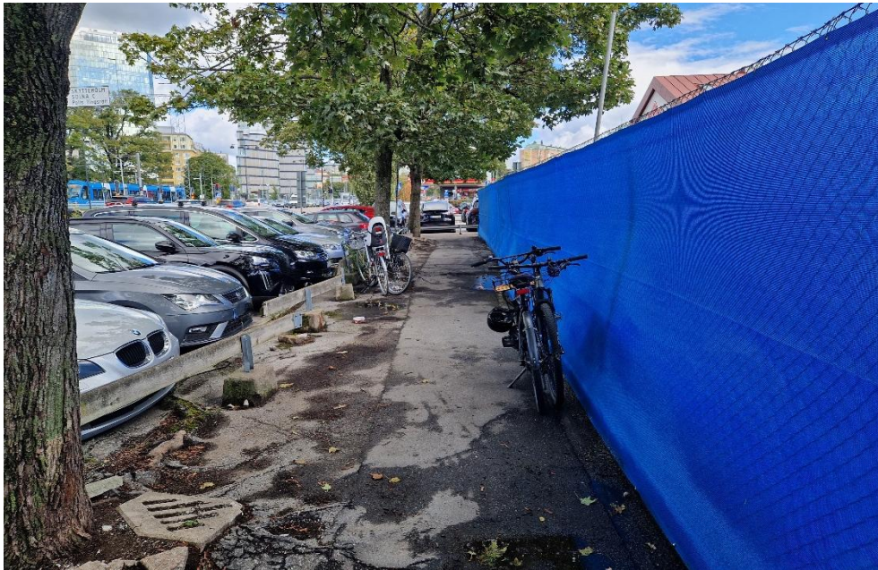
Figur 14 Cyklar uppställda på gångytan mellan parkeringen och omklädningsbyggnaden
