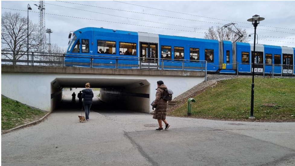
Figur 7 Gångtunneln nordost om Skytteholms IP. Bilden är tagen från norra sidan av Frösundaleden med vy söderut. Foto: Nicole Byskén, 2025-04-09.
