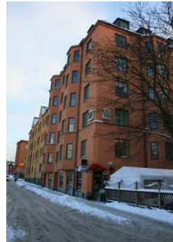
Befintlig bebyggelse på Råsundavägen.
