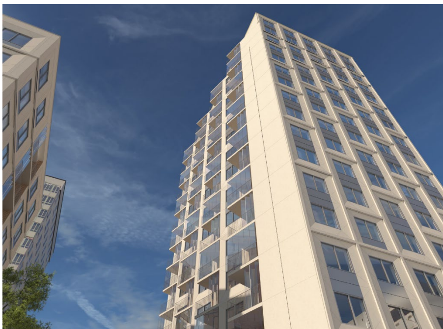
Punkthusets förskjutna balkonger ger ett intressant fasadmotiv och skapar lägre ljudnivåer på balkong
