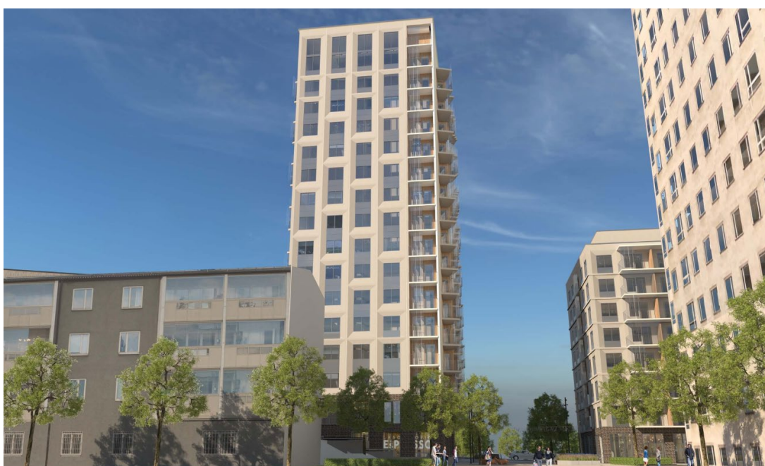
Punkthuset i 17 våningar sett från väster mot centrumtorget
