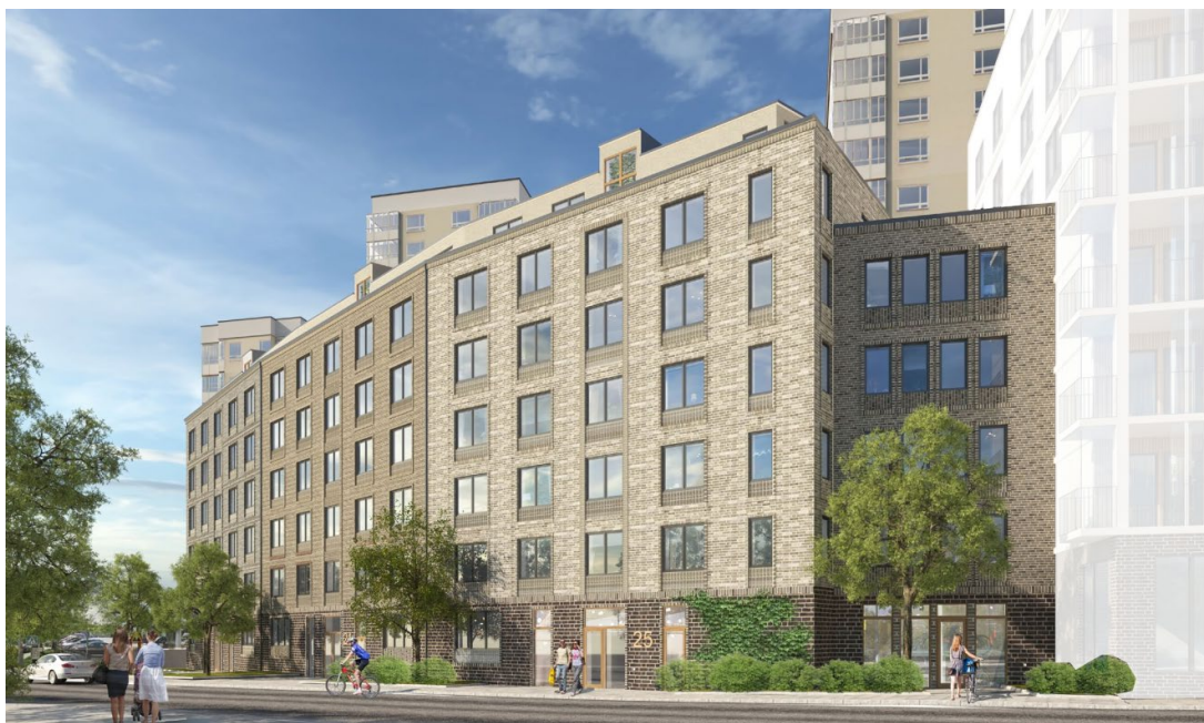
Lamellhusen i södra delen av planområdet, vy från norr
