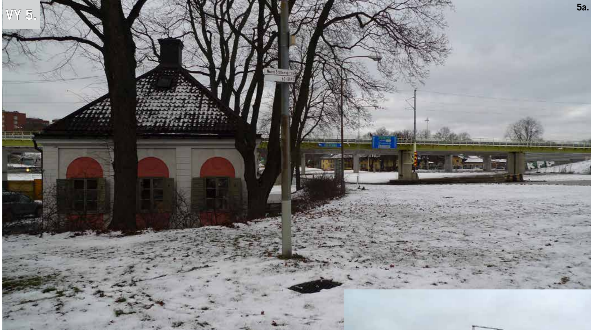
5a. Vy från trottoaren söder om det östra tullhuset, 2016-11-29. Den gulgrönmalade äldre järnvägsbron kommer att rivas. KMA Stallmästaregården sid. 38.
