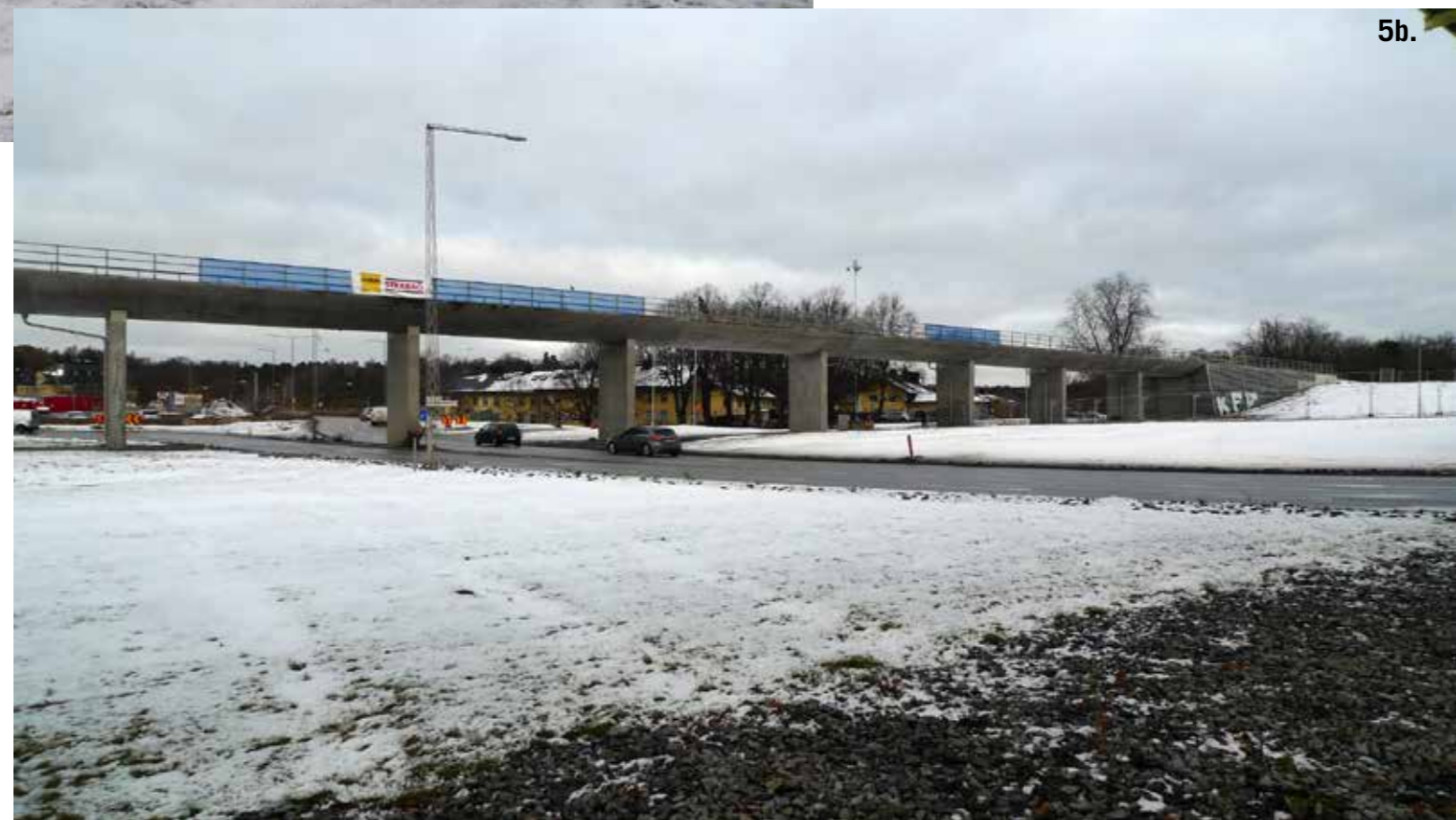
5b. Från området under den järnvägsbro som kommer att rivas, 2016-11-29. KMA Stallmästaregården sid. 38.
