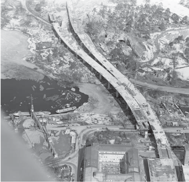
Ovan: Flygfoton över uppförandet av Karlbergsbron och tunnelbanans framdragning under marknivå strax öster om bron. Foto Erik Claesson. Källa Riksantikvarieämbetet
