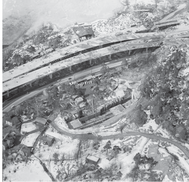
Ovan: Flygfoton över uppförandet av Karlbergsbron och tunnelbanans framdragning under marknivå strax öster om bron. Foto Erik Claesson. Källa Riksantikvarieämbetet
