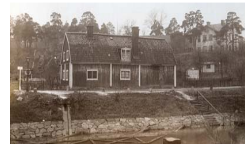
Lilla Hornsberg vid Karlbergs kanal. Före ombyggnaden 1956. Odaterat foto. Källa: Solna stads bildarkiv
