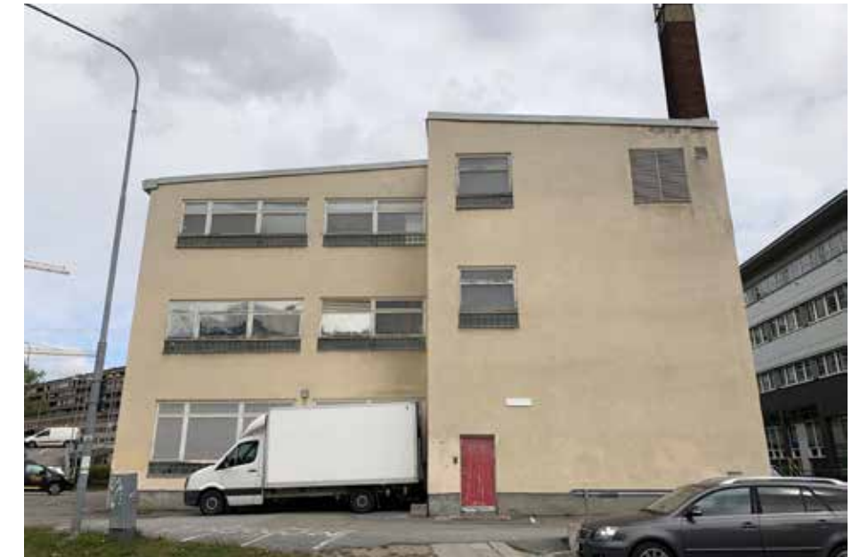
Södra gaveln, med en ursprunglig trädörr till södra trapphuset.
