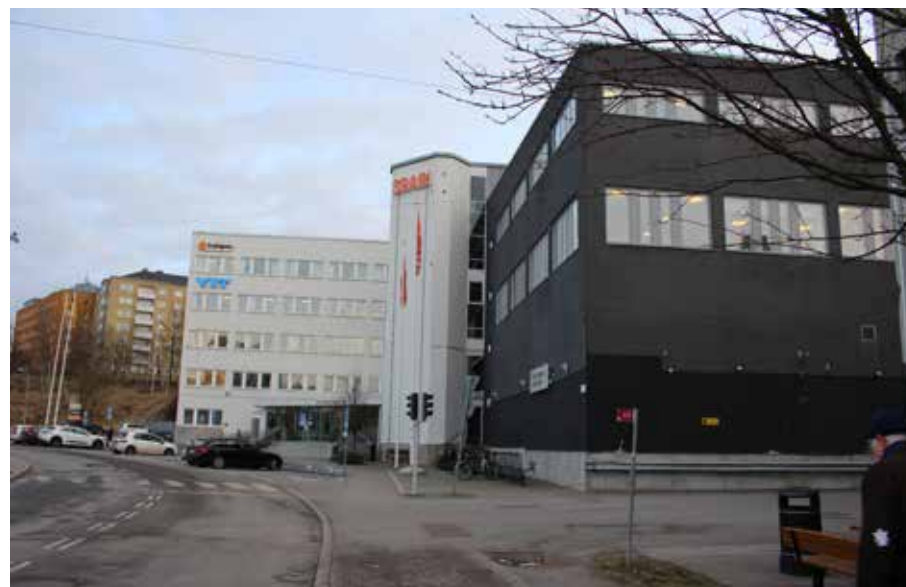
Fräsaren 10. Delen närmast Svetsarvägen.
