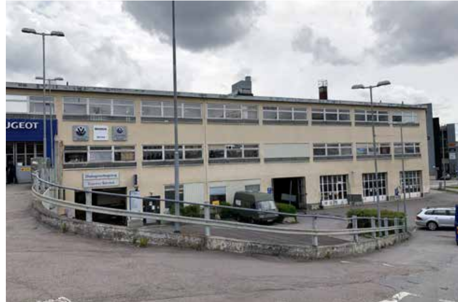
Västra fasaden, verkstadsdelen ligger i suterräng. Den svängda infartsvägen ovan stödmuren är ett karakteristiskt inslag. Anläggningen är det gamla verksamhetsområdets bäst bevarade byggnad, där den ursprungliga funktionen är lätt avläsbar.
