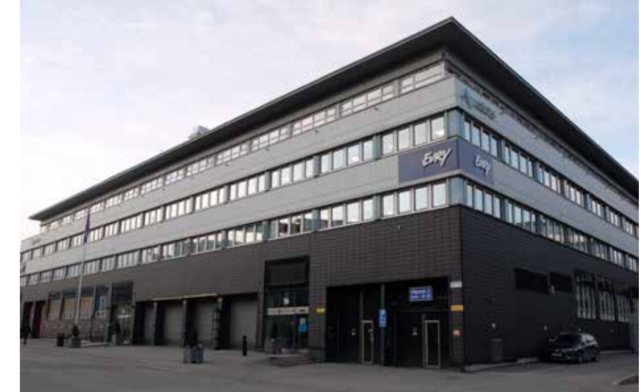
Sliparen 2 från Englundavägen. Byggnaden har genomgått stora förändringar i fasad 2003.
