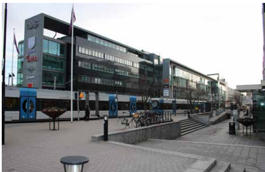
Fastigheten Smeden 1 ligger centralt i mitten av övriga fastigheter i Solna Business Park. Byggnaden frontar Svetsarvägen, här återfinns en av tvärbanans hållplatser.
