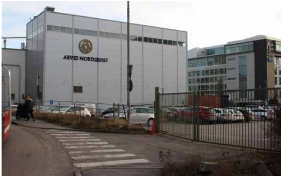
Verkmästaren 4 mot järnvägsspåret.
