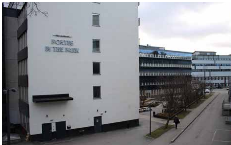
Svetsaren 1 hus 1. Den upplevda baksidan av byggnaden ligger på en lägre nivå än den avgränsande Ekensbergsvägen. På den västra sidan används utrymmet som park.
