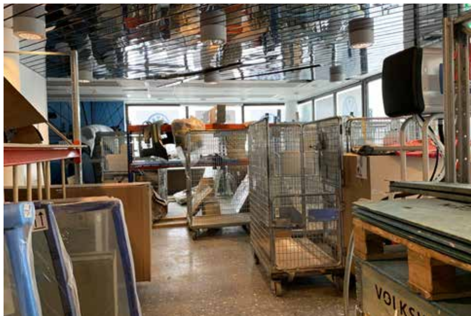
Den före detta bilutställningslokalen i norr, plan 2. Planlösning och de flesta ytskikt sentida, men ursprungligt cementmosaikgolv. Längst bort skymtar ett utrymme vid nordvästra hörnet som har ett äldre, eventuellt ursprungligt, undertak med infällda armaturer.
