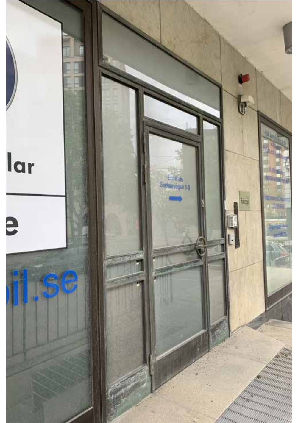
Den glasade entrédörren i koppar med sido- och överljus är ursprunglig.
