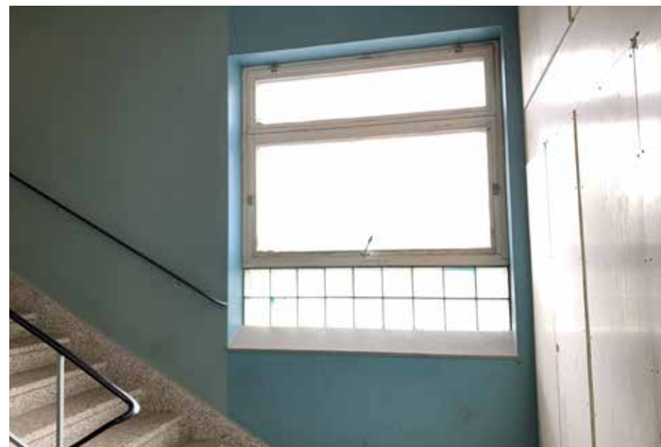
Södra trapphuset, mot söder.
