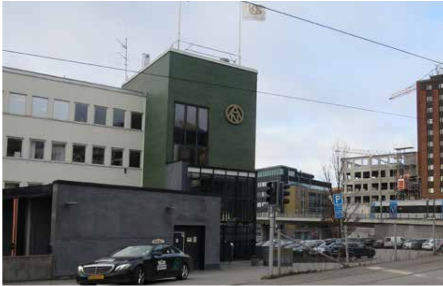
Arvid Nordqvist industrifastighet, Verkmästaren 4, mot Svetsarvägen.
