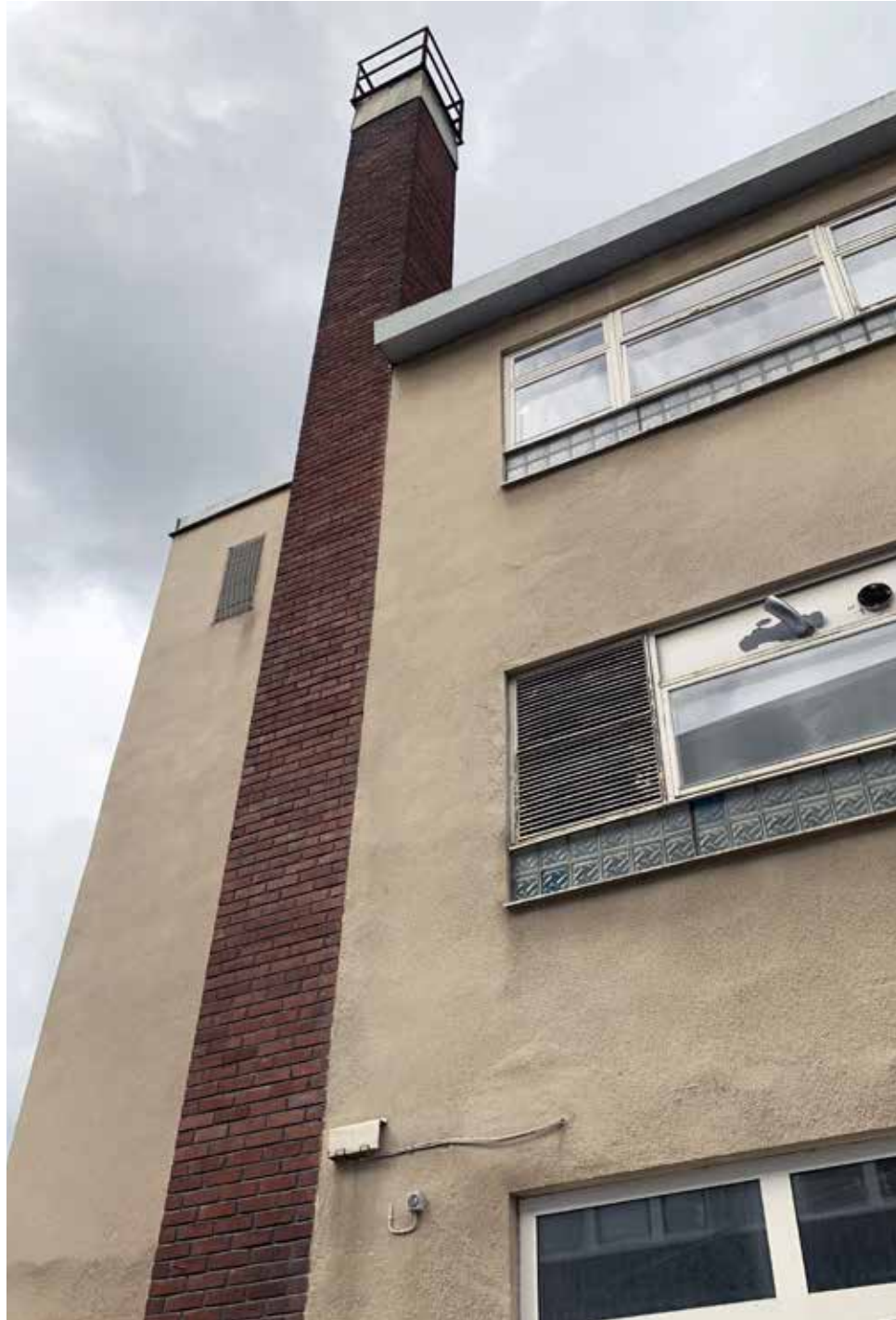
Hörnet mot sydöst. Den gulbeiga putsen är sannolikt ursprunglig.
