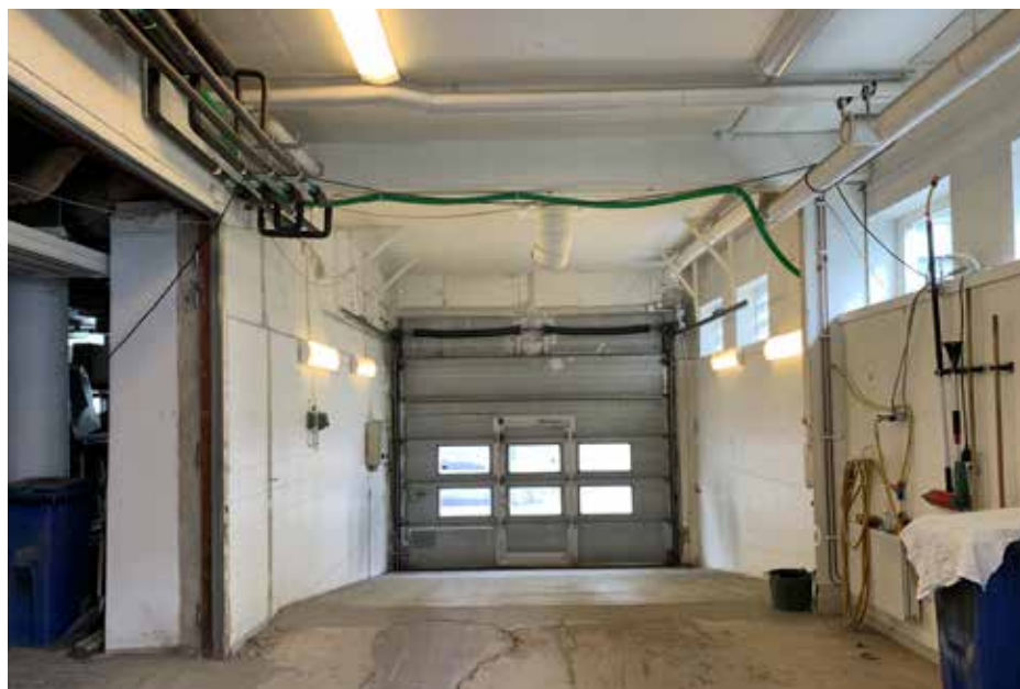
Utfarten mot Ekensbergsvägen plan 2, till vänster skymtar den före detta bilutställningslokalen.
