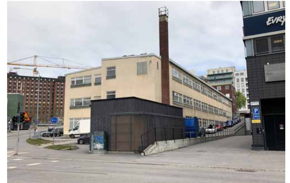
Från sydöst. Den mörka byggnaden i förgrunden är en sentida elcentral. Sliparen 2 till höger är en kraftigt ombyggd 1960-talsanläggning.
