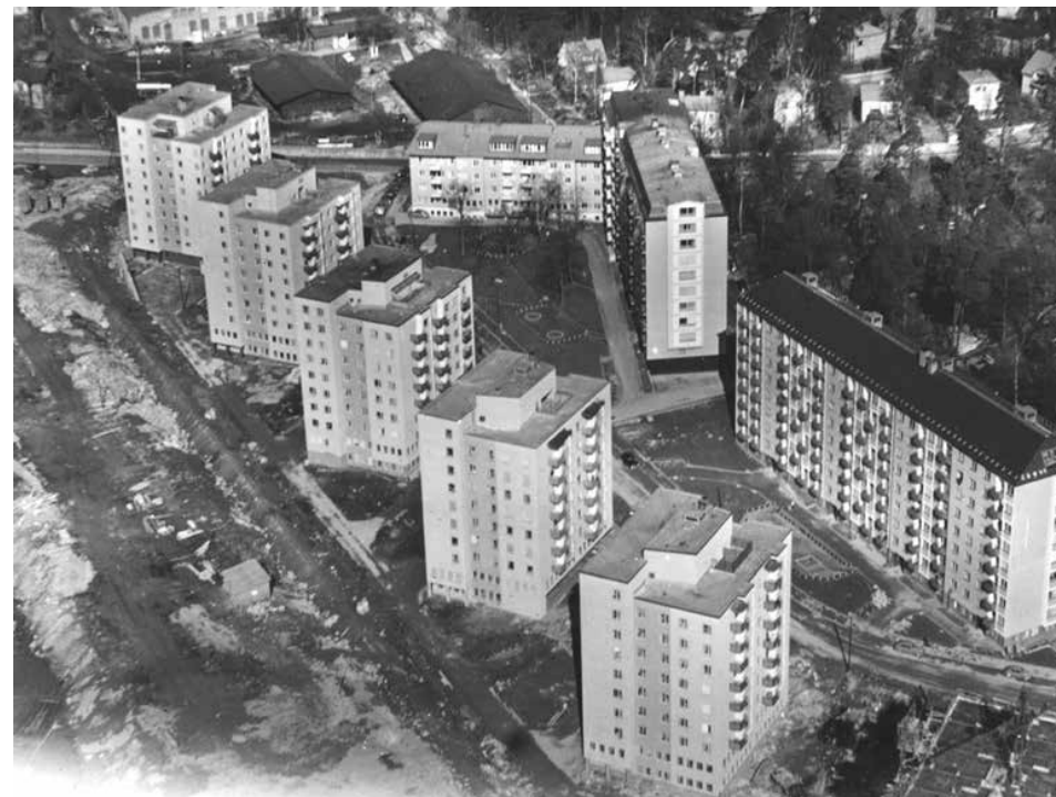
På bilden tagen 1957 pågår arbetet med Grängsgatan, den nya kopplingen mellan Ekensbergsvägen och Frösundaleden. Källa: Solna bildarkiv.
