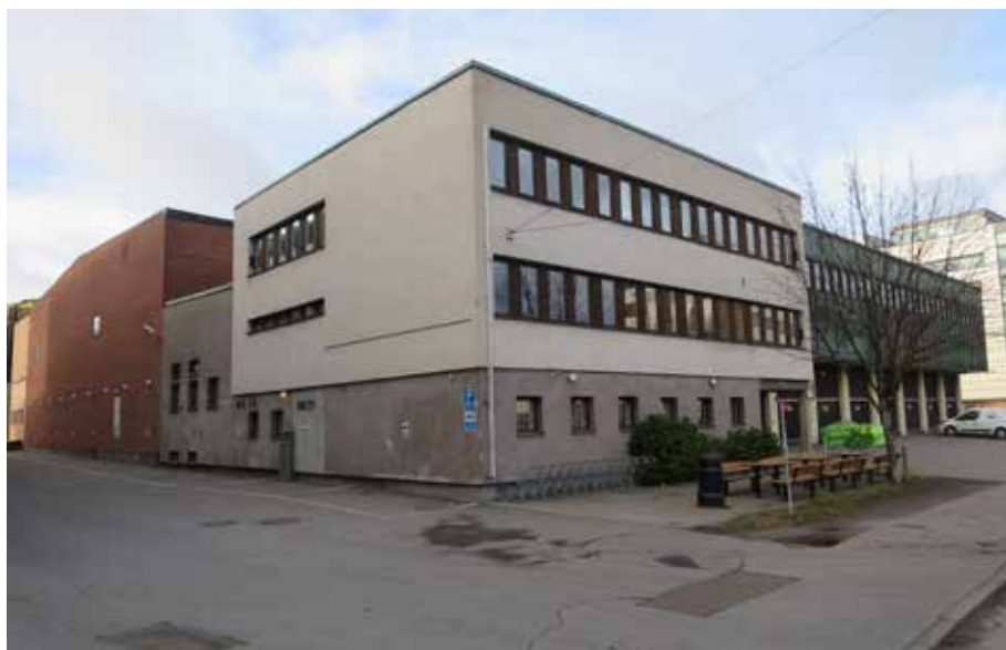
Fräsaren 9. Fasad mot Svetsarvägen.
