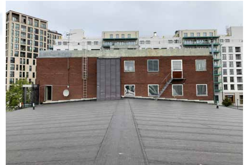
Verkstadsdelen har pappbelagt tak, högdelen i bakgrunden har plåttak. Fasadens utbyggnad i brun plåt är sekundär
