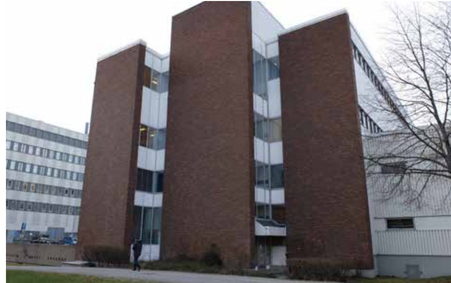
Yrket 3, fasad mot sydöst.w
