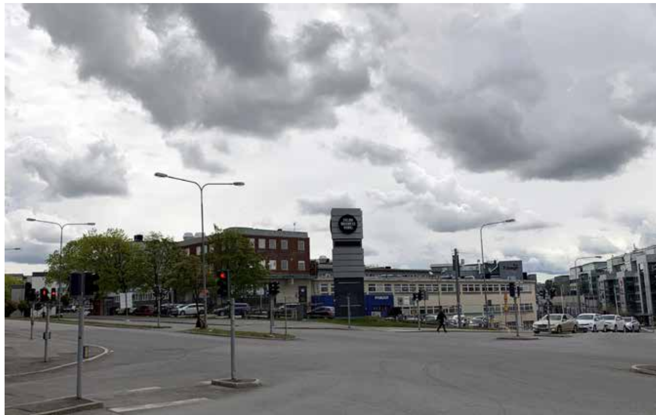
Anläggningen sedd från den siktlinje som bildas utmed Prästgårdsgatan i Sundbyberg.
