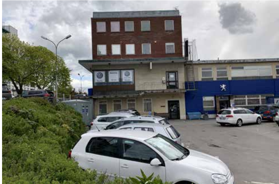
Högdelen från väster, med sidoentréer som leder till norra trapphuset och kontorsvåningarna. Slänten vid gatan har hanterats genom en tuktad markkrypande buske.
