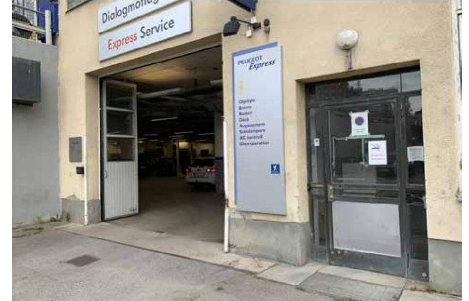
Infart till norra delen av nedersta planet, plan 0. Till höger ett ursprungligt dörrparti i koppar, likadant som det mot gatan. Sannolikt är det flyttat från sidoentrén i plan 2.
