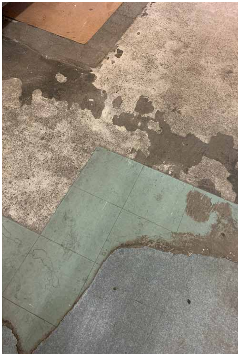
Överlappande tidslager av golvmaterial i ett förråds- och kontorsutrymme, på platsen för den ursprungliga lunchmatsalen.
