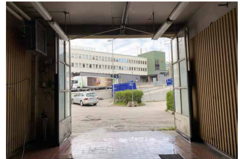
Biltvätt i 1960-talsskick, plan 0, med rött klinkergolv och väggar i anodiserad aluminium.
