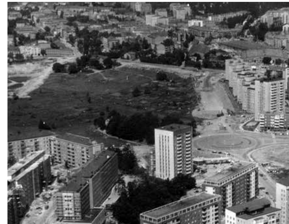
Bilden från 1959 visar området som året efter började exploateras med verksamhetsbebyggelse. Dagens kvarteret Sliparen är beläget i fonden, där grönska och småskalig bebyggelse skymtar. Källa: Solna bildarkiv.
