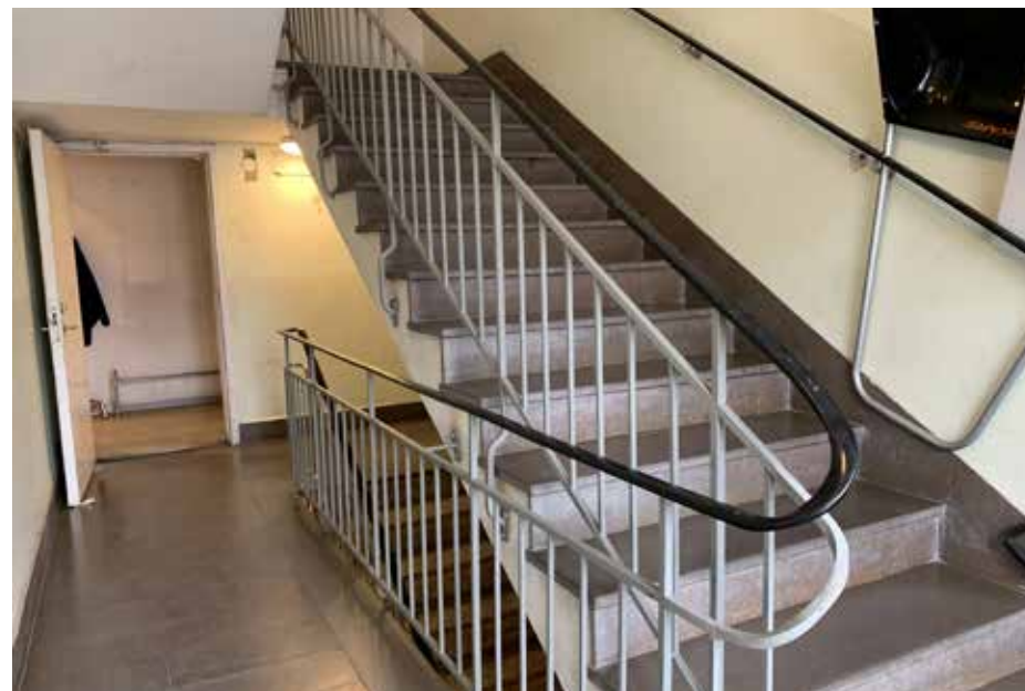
Norra trapphuset. Från plan 2 och uppåt med golv och steg i kalksten. Trapphusets dörrar är generellt sett utbytta.
