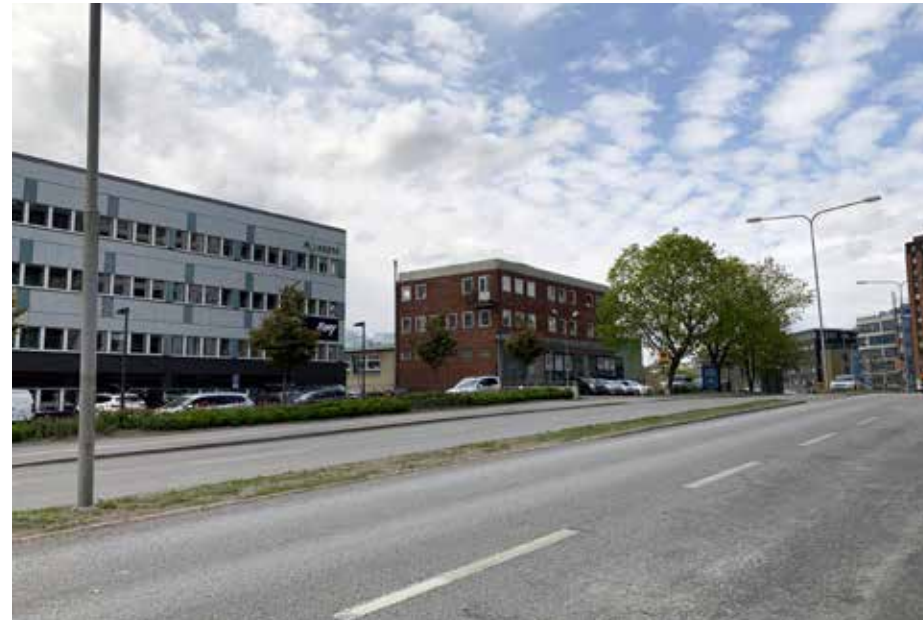
Anläggningen så som den annonserar sig invid Ekensbergsvägens stora gaturum. Här är Sliparen 1 ett lätt avläsbart inslag i den historiska stadsmosaik.
