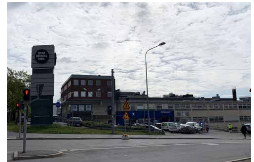
Sliparen 1 från väster med Svetsarvägen i förgrunden.
