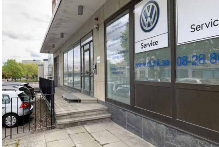
Vid huvudentrén finns en liten avsats med smidesräcke. Fönsterpartierna är bytta.
