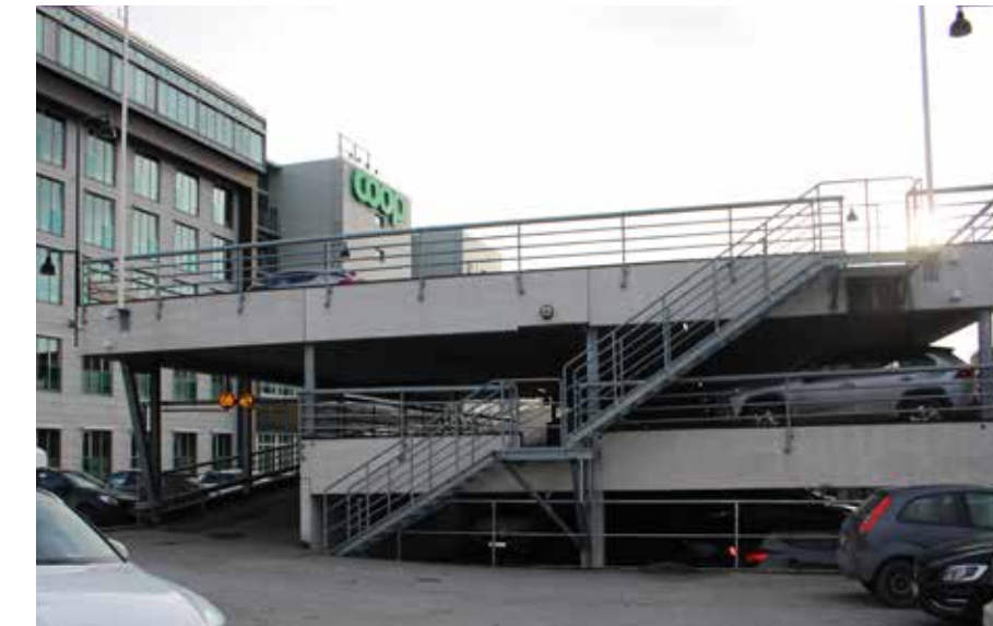
Fräsaren 11. Parkeringsdäck i flera våningar bakom byggnaden.
