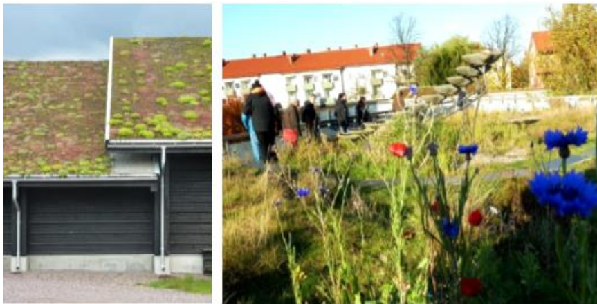
Figur 20: Exempel på gröna tak. Till höger tjockare gröna tak och till vänster tunnare gröna tak (källa: WRS AB, 2017 rev. 2019)
