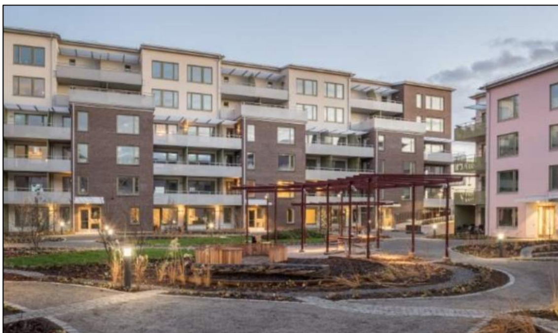
Figur 5-3. Avledning av takvatten till planteringar via rännalar anlagda i gatsten. Exempelillustration från Linnéhuset i Uppsala (Källa: Uppsalahem).
