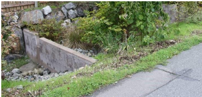
Figur 15 Exempel på dikesgestaltning med betongtrösklar och växtlighet.
