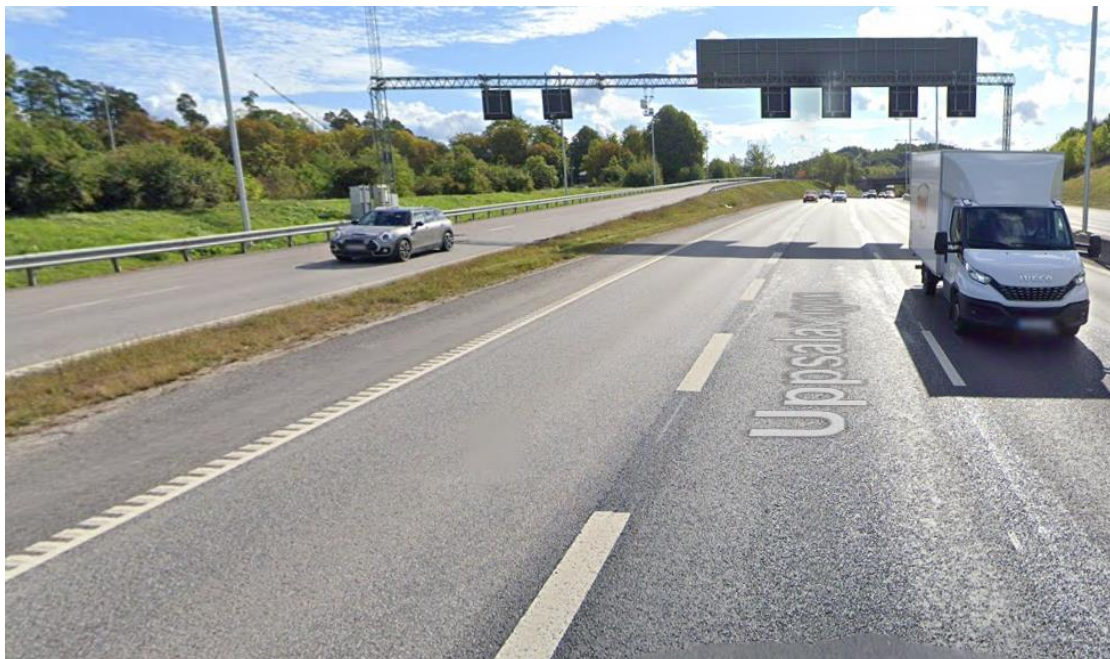
Figur 16. Översiktsbild av påfartsvägen (E4 norrgående, men blickar söderut) och diket längs med påfartsvägen som är en naturlig invallning.
