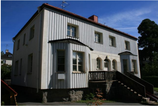
Höjers villa. Fasad mot Charlottenburgsvägen.
