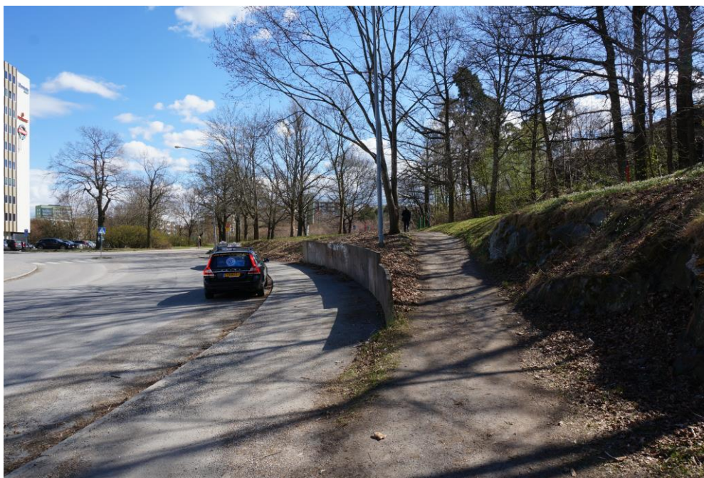
Gångbana längs Hemvärnsgatan som tas bort (till vänster) och gångväg genom parkområde som rustas upp (till höger)
