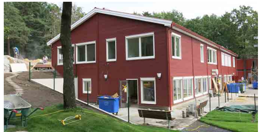
De sista arbetena vid Näckrosens förskola tar form
