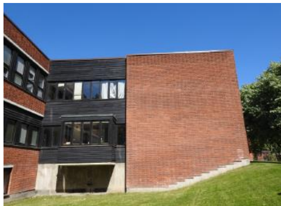
Burspråket på sydgaveln av hus 4 är en av få arkitektoniska accenter på byggnaden. Lagg märke till den trappformade mönstermurningen i slänten.
