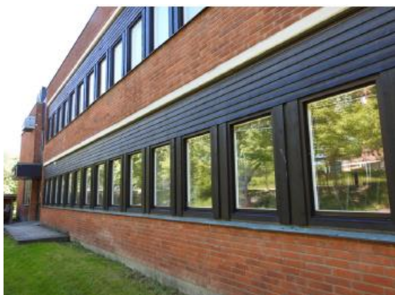
Nordfasad med i rött fasadtegel och karaktäristiska horisontella band i mörklaserad fjällpanel.
