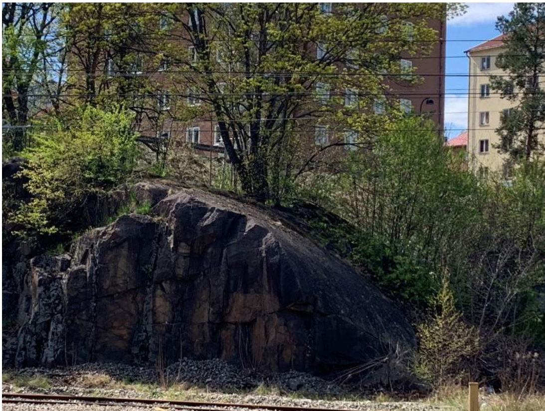
Figur 7 - Övergång bergslänt till berg i dagen
