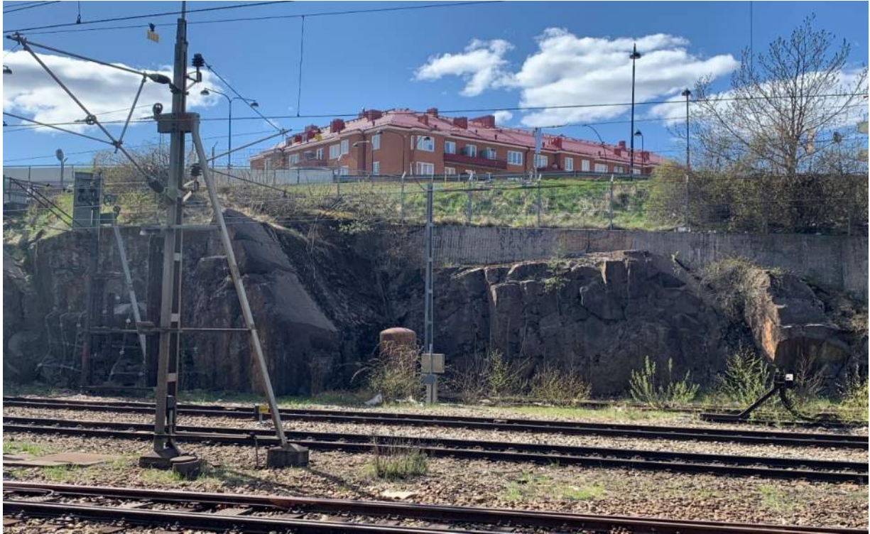
Figur 4 – Bergslänt med stödmur
