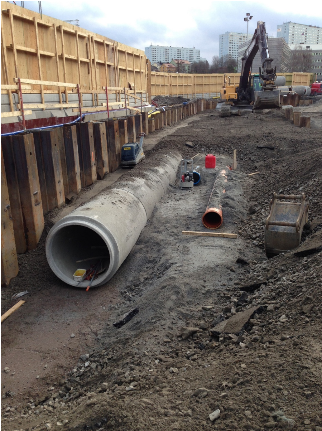
Foto från tidigare ledningsomläggning invid Råsta Strandväg/Pyramidvägen. Dessa ledningar passerar föreslagen cirkulationsplats enligt illustration föregående sida.
