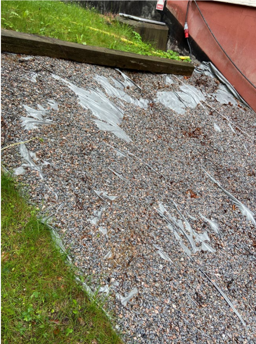
Figur 7. Parkslide täckt med presenning och grus vid objekt 2.
