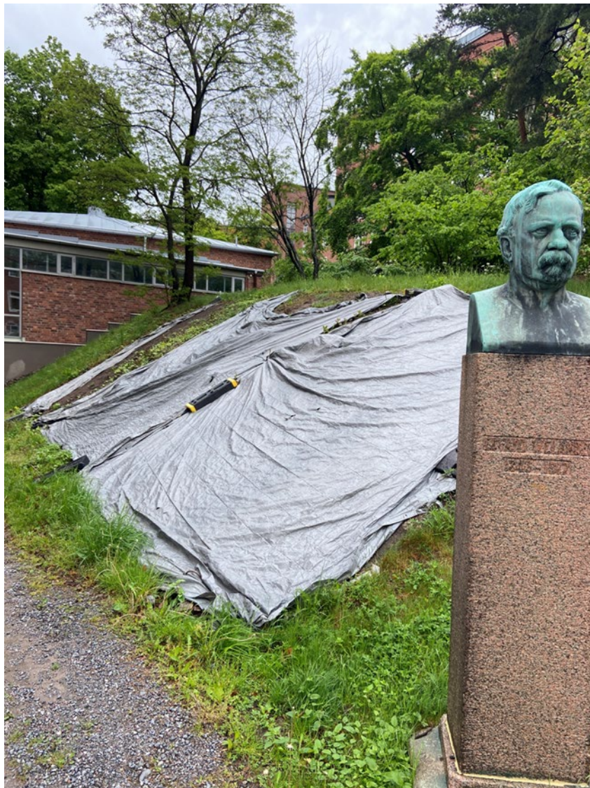
Figur 6. Parkslide i sluttning vid objekt 1.
