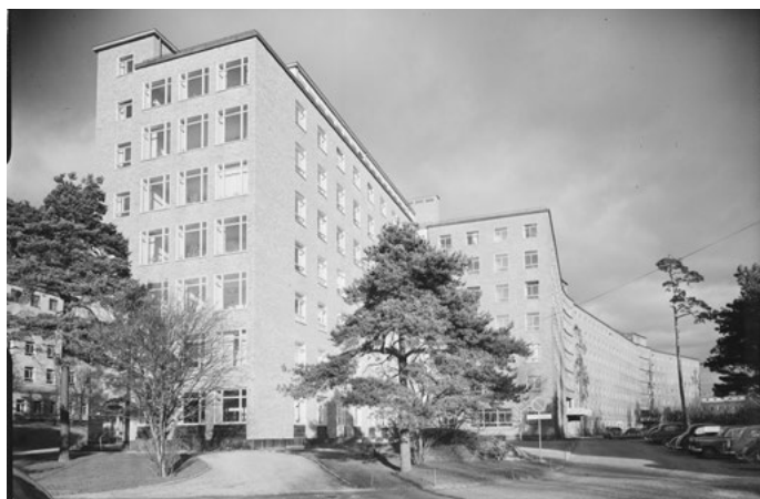
Huvudbyggnaden från väst. På bilden syns den karaktäristiska svagt svängda volymen som vänder sig emot sjukhusparken. Parkmiljön smyger sig in mellan byggnadsvolymer. Uppbrutna volymer och fönstren skapar variation. Bild: Sune Sundahl 1954. Källa: Digitalt museum.
