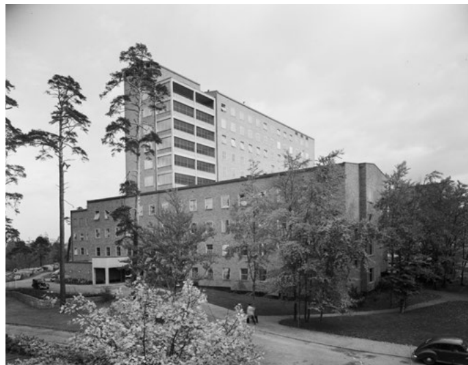
Bebyggelsen har karaktären av hus i park. Grönstrukturen binder samman området och utgör ett eget gestaltat element.
