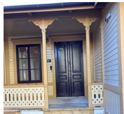
Förstuvistar och spröjsade fönster
