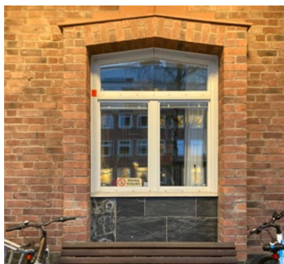
Omfattning kring fönster på huvudbyggnad. Bröstning i natursten.
