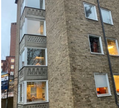
Tidstypisk fasadutsmäckning och perspektivfönster på tidigare elevhem.
