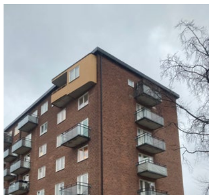
Putsade fasadpartier utgör ett vanligt förekommande element. Takfotens enkla form.
