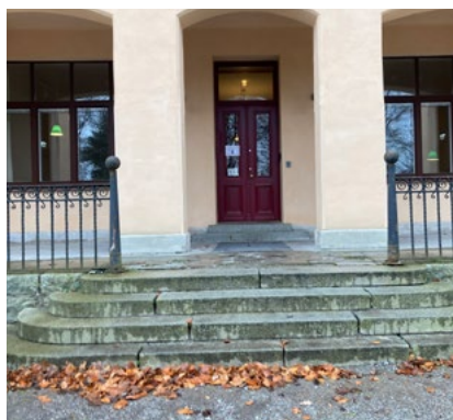
Stentrappor med rundad form och dekorativt utformade järnräcken.
