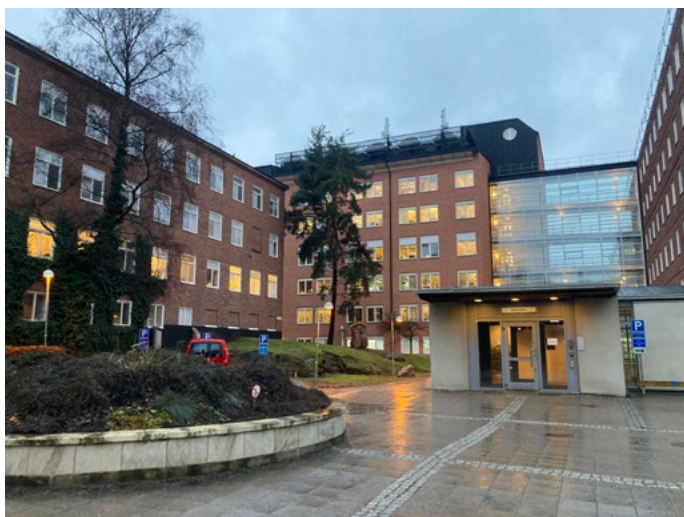
Anläggningen har byggts ut under olika tidsskeden, vilket resulterat i ett varierat uttryck. Skalan och teglet håller ihop bebyggelsen.
