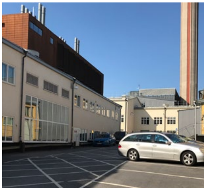
De ljusa fasaderna, de stora fönsterpartierna och fönsterbanden utgör ett tydligt för den funktionalistiska stilen. Skorsten markerar pannrummet.
