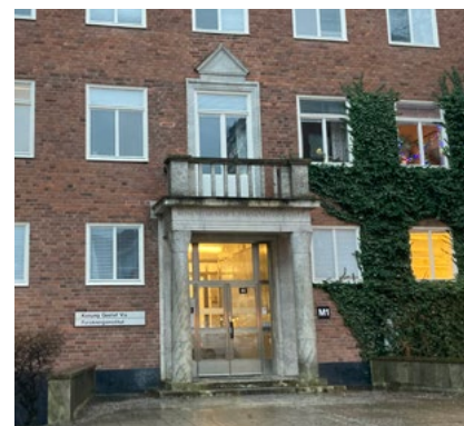
Entréparti med klassicistisk prägel. Entrépartiet är utformat i marmor och ger byggnaden ett monumentalt uttryck.
