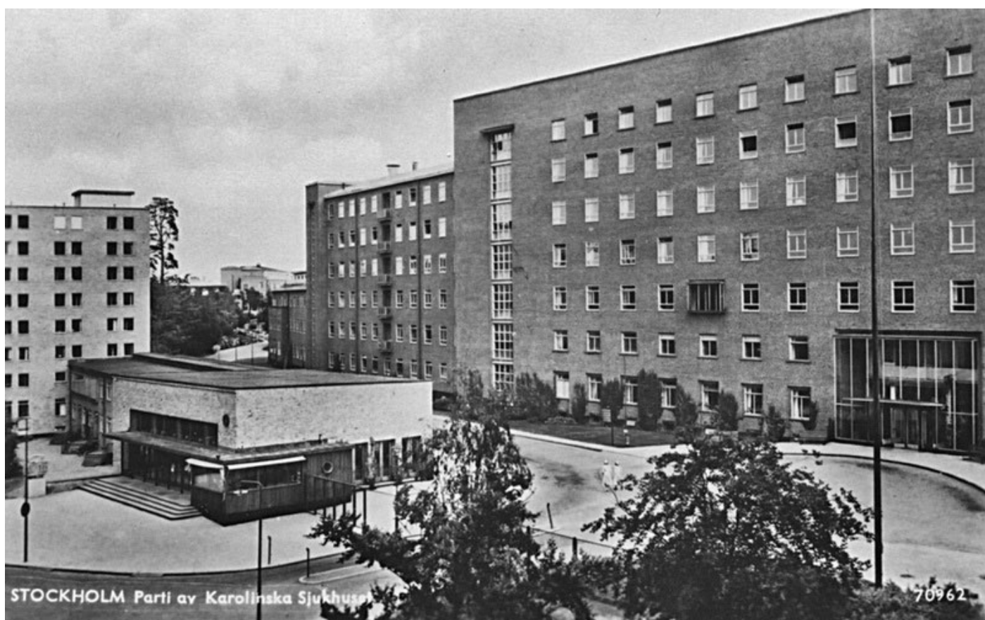
Vykort med del av Karolinska, 1940-tal. Till höger huvudbyggnaden. På fasaden syns ett burspråk och ett vertikalt glasparti som bryter av den annars repetitiva fasadupbyggnaden. Till vänster post- och apoteksbyggnaden samt elevbyggnaden. Källa: Solna Bildarkiv
