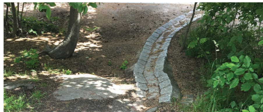
Befintlig rännal i storgatsten vid Mönstringen 3
