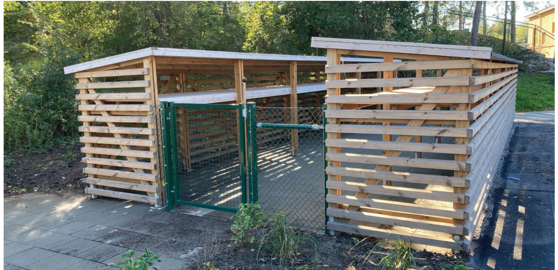
Barnvagnsförråd vid förskola i Tyresö
