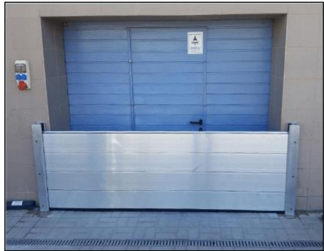
Figur 19 Exempelbild översvämningsskydd för byggnader. Källa: (Hydratec, 2021).
