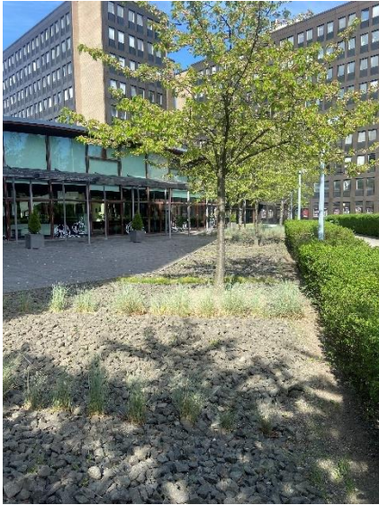
Figur 25. Lågpunkt 3, upphöjd växtbädd med grustäcke.
