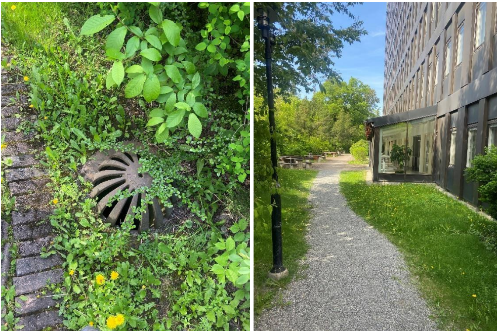
Figur 26. Lågpunkt 4, brunnar intill västra kanten och översiktsbild över området med mindre lokala lågpunkter.
