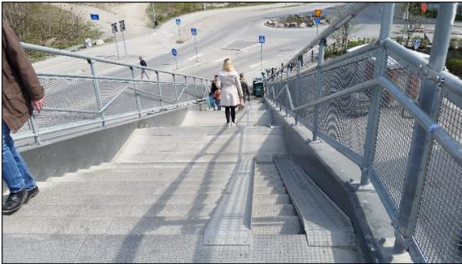
Figur 3-1 Trappa från Målbron till Gårdsvägen-Kolonnvägen (Foto WSP)
