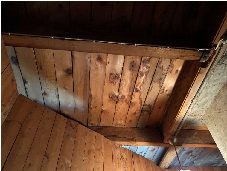
Figur 3-4 – Bjälklag utförts med träbalkar
