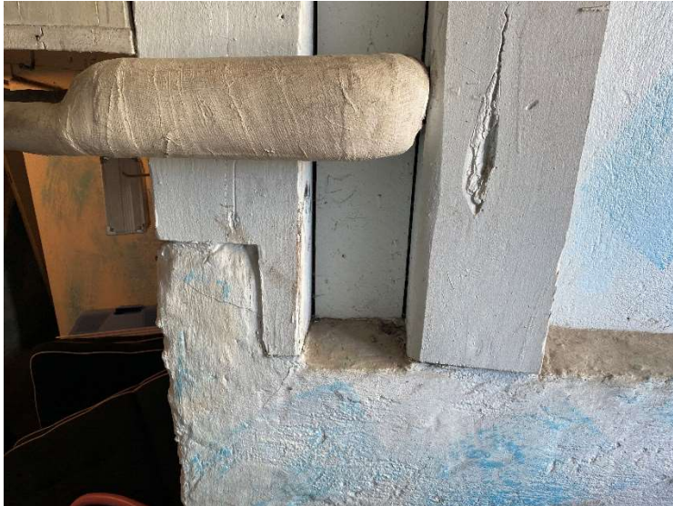
Figur 3-5 – Träpelare som grundläggs på källarens väggar
