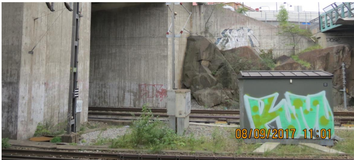
Figur 16, Signalkiosk 1105, Foto: Sweco
