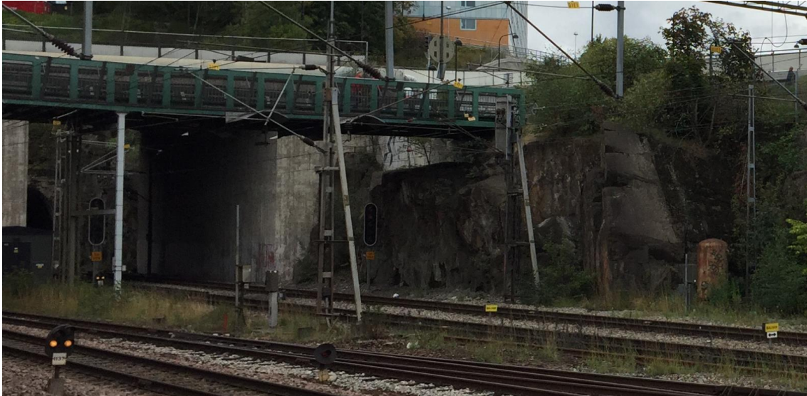
Figur 9, GC-bro och bergssida väster om spårområdet. Foto Sweco.
