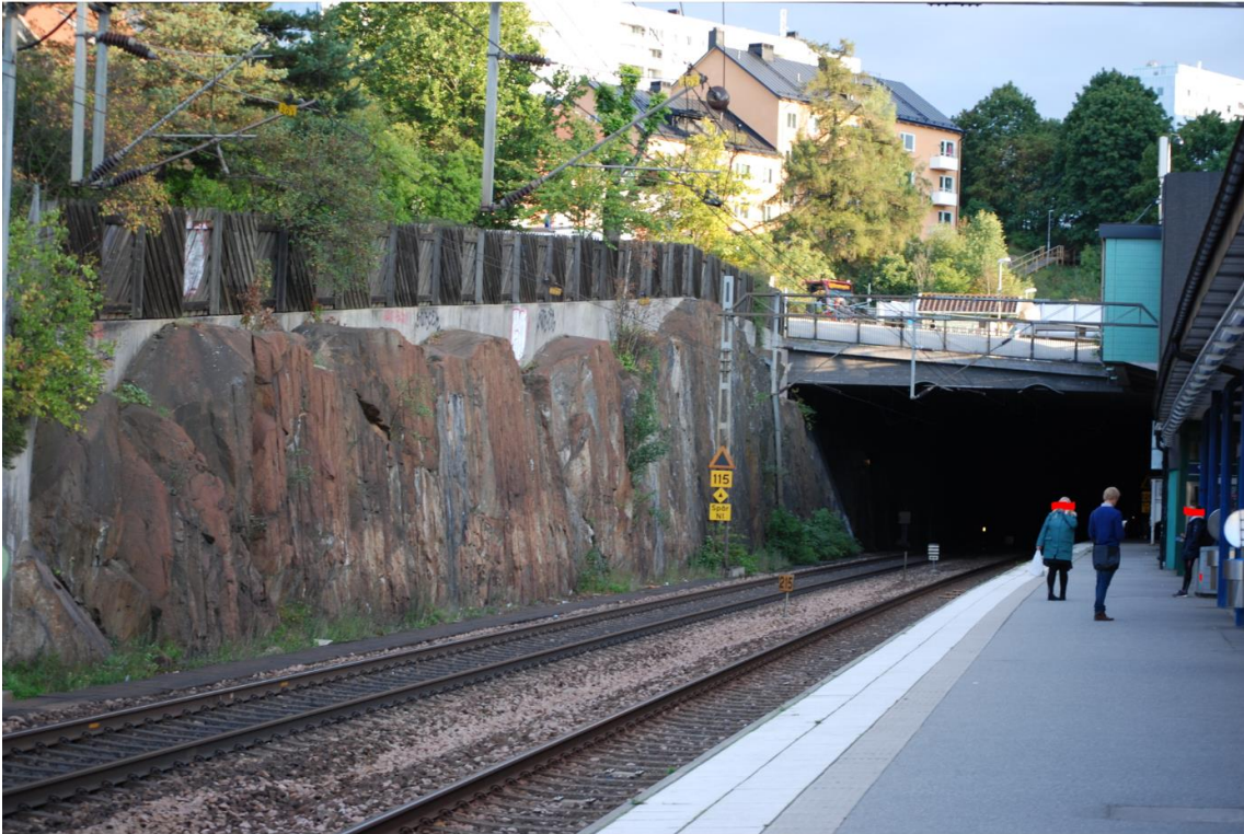
Figur 11, Bergssida öster om spårområdet, konsolande del av stationshus. Foto Sweco.
