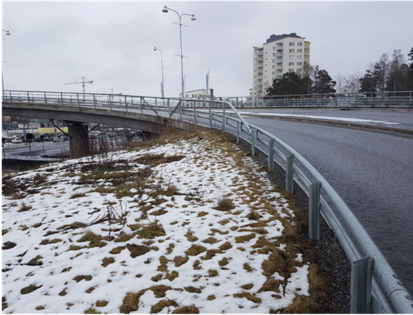
Figur 3: Påfartsramp på uppfyllt jordramp.
