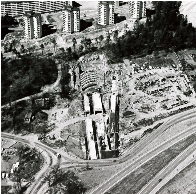
Figur 3 Flygfoto över tunnelbanebygget. Denna bild visar att schakten för betongtunnlarna inom lerområdet utfördes inom spont, men med en rampväg ner från södra sidan. Utdrag från "The Stockholm underground, 1975, A technical description."
