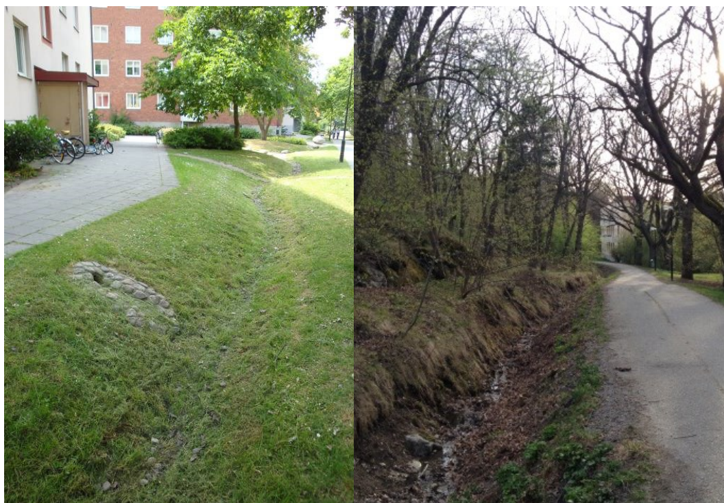
Figur 10. Exempel på utformning av svackdiken utan kantsten och avskärande dike i skogsområde.
