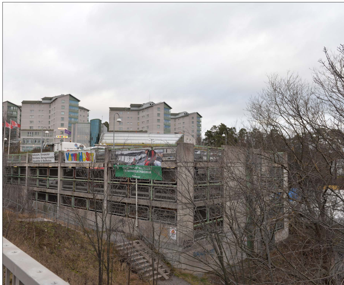
Befintlig parkeringshus med plats för 248 bilar
