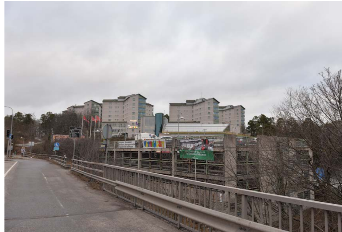
Parkeringsdäcket vid Roslagsvägen som ianspråktar stor del av tomten
