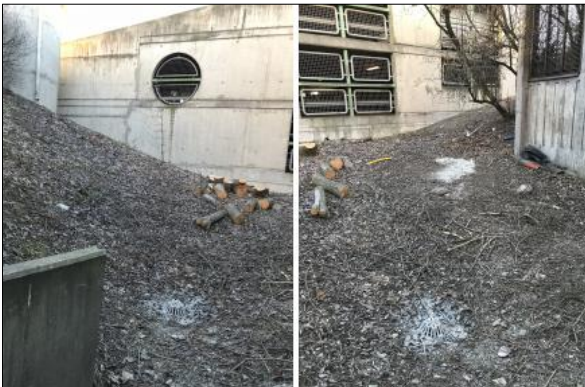
Figur 3-11. Bilder i riktning mot parkeringshusets norra gavel. Vänster bild riktning västerut, höger bild riktning österut. Kupolbrunn för dagvatten syns i förgrunden. Till höger syns byggnaden precis norr om parkeringshuset. Denna ligger på tomten norr om Triangeln S:1.
