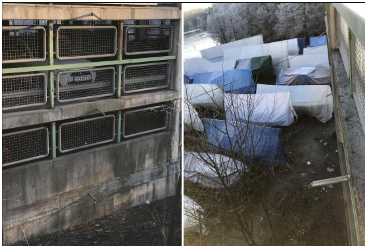
Figur 3-10. Avrinning av dagvatten ifrån parkeringshuset sker igenom avtappningsrör i betongen vilka finns på varje våningsplan.
