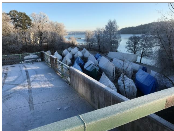
Figur 3-6. Vy mot sydväst ifrån parkeringshusets tak.
