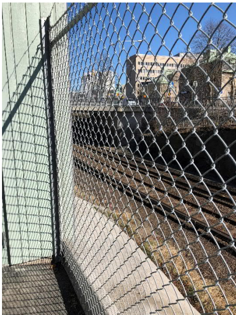
Fig 8.3 Gräns mot spårområdet med sluttande mark ner mot spåren
