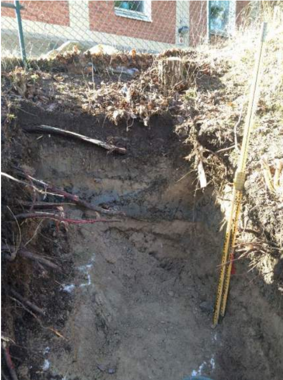
Figur 1: Provgrop 2 med berg synligt i botten av gropen.
