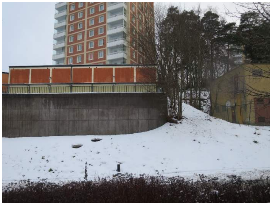
Figur 2.4: Stödmur, garage och flerbostadshus söder om befintlig nätstation.
