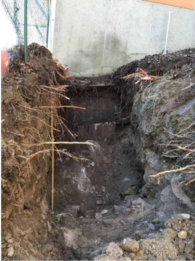
Figur 1: Provgrop 1 med berg synligt i botten av gropen.
