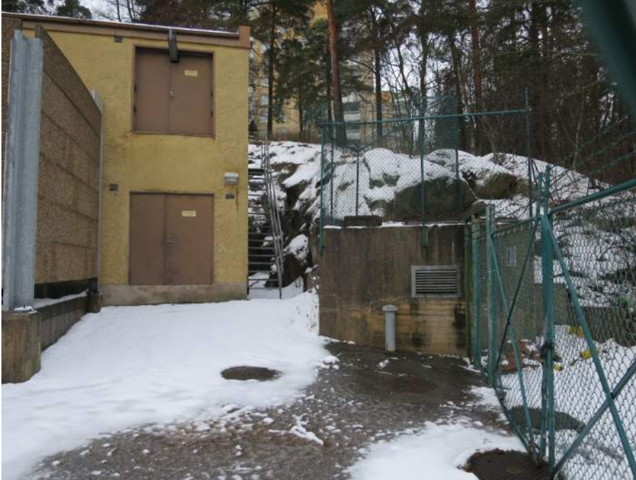
Figur 2.2: Sprängd bergslänt norr om befintlig nätstation.
