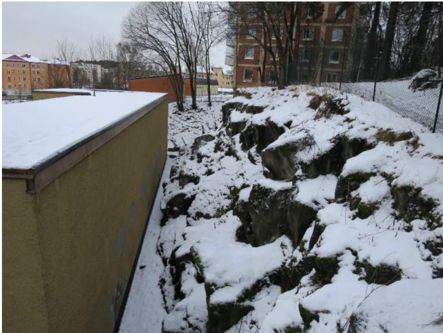
Figur 2.1: Sprängd bergslänt väster om befintlig nätstation.
