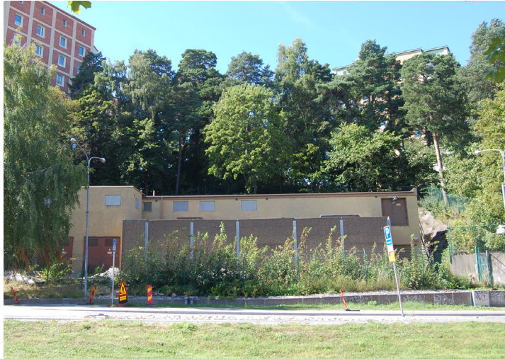
BEFINTLIG SITUATION PÅ PLATSEN
