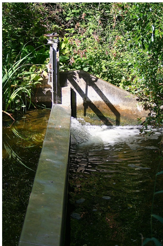
Figur 4 Råstasjöns regleringsdamm med bräddavlopp och utskov.
