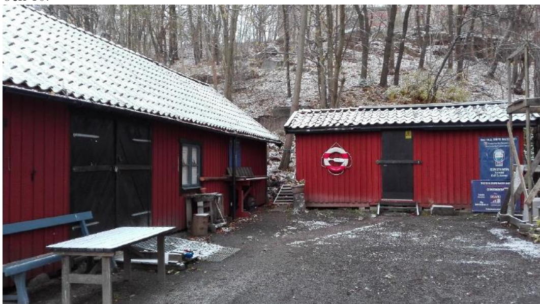
Figur 9. Husen ovanpå den befintliga utloppsledningen
