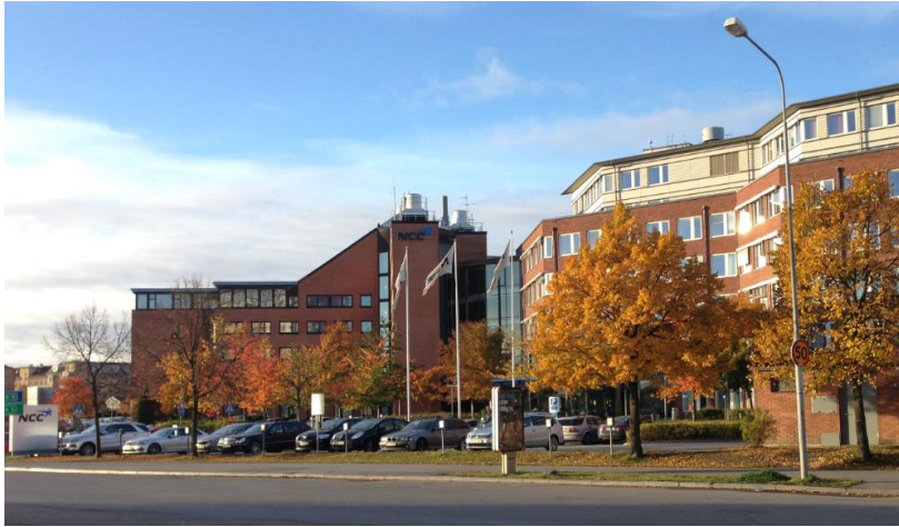
Nuvarande kontorsbyggnad, vy från Vallgatan
