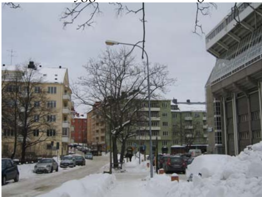
Norra läktarfasaden mot Råsunda torg
