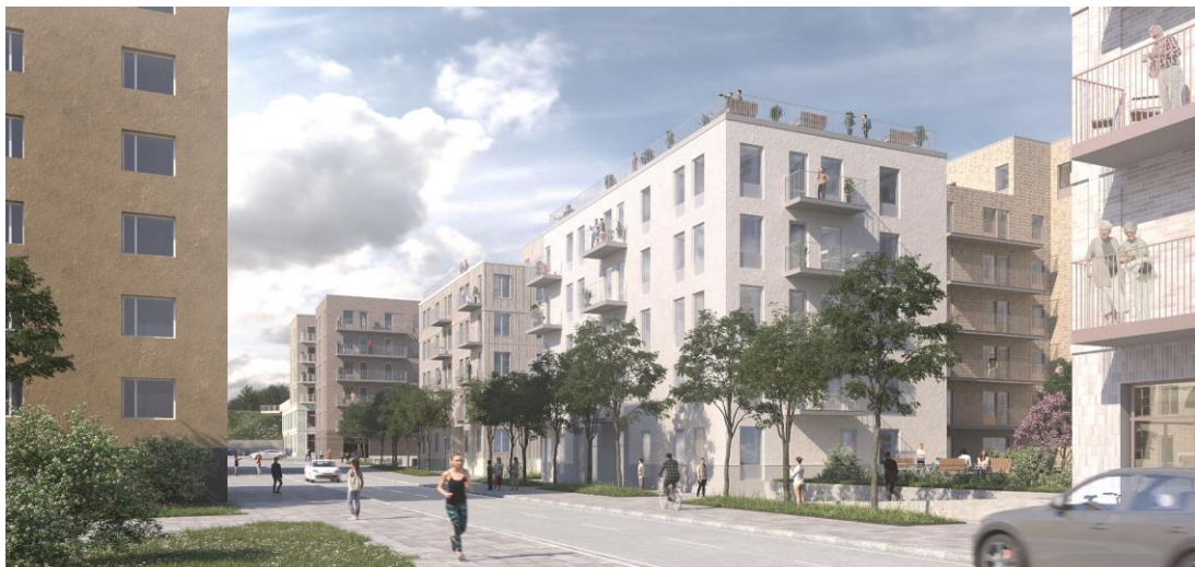
Vy Jonstorpsvägen (ny bebyggelse till höger och i fonden, befintlig till vänster)
